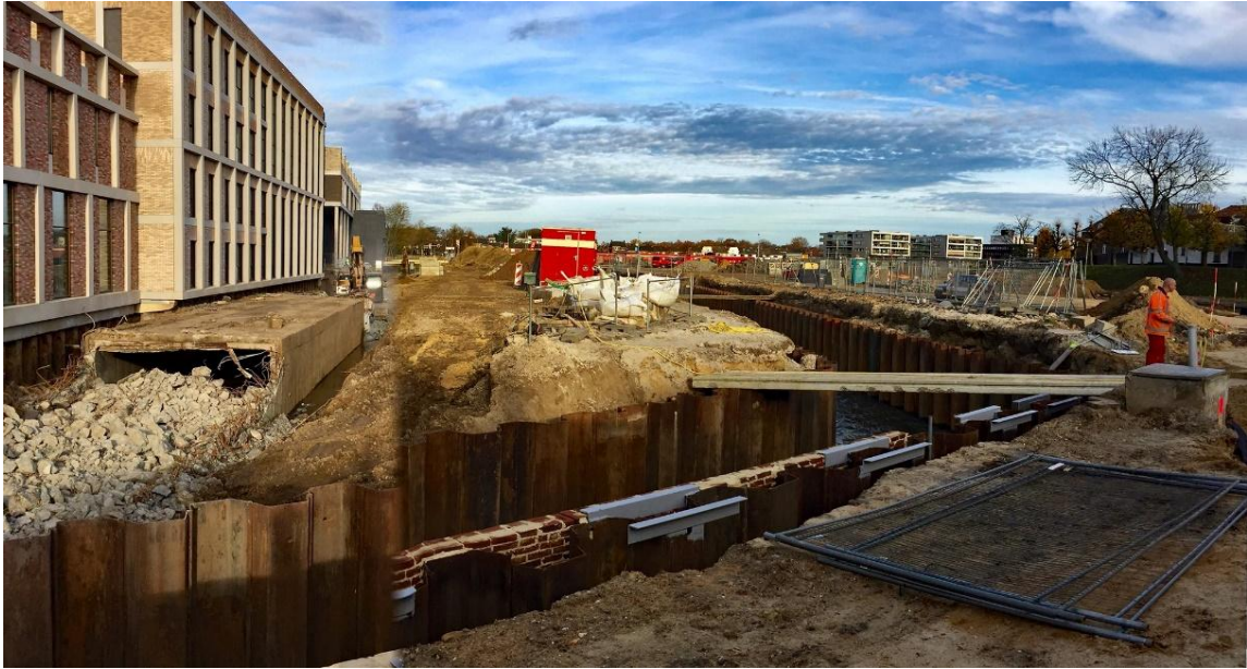
Figuur 189: Omleiding Keutelbeek, met links de betonnen overkluizing van de Keutelbeek
