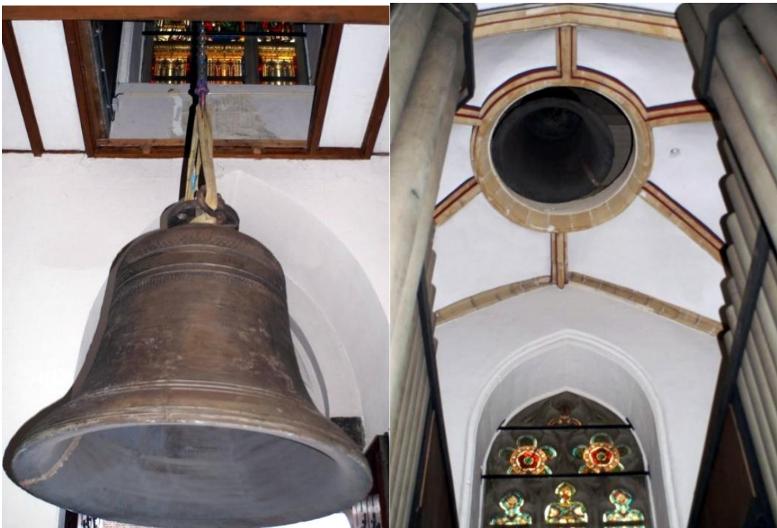
Figuur 78: Opening in het plafond van het voorportaal en in het plafond boven het orgel
