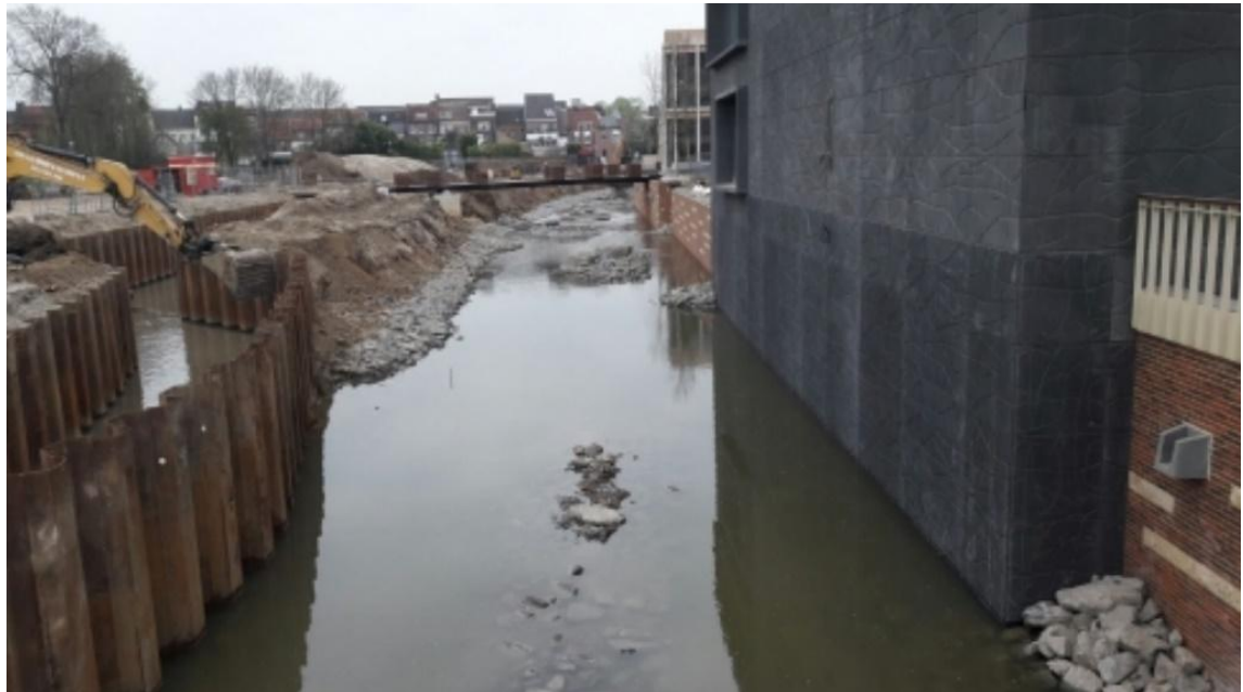
Figuur 190: Links de tijdelijke omleiding van de Keutelbeek om deze te kunnen 'ontkluizen'
