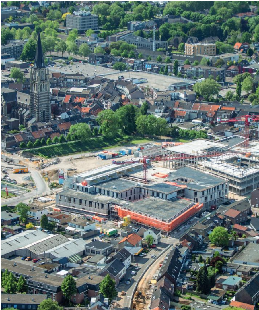
Figuur 188: Bouw van de Ligne gaat snel (linksboven het gemeentehuis in de Baenje en onderaan de Rijksweg)
