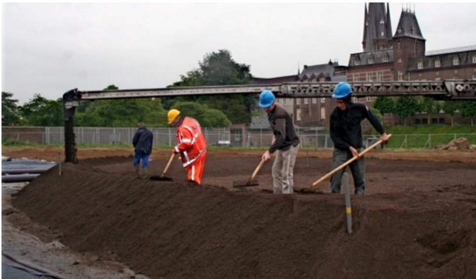
Figuur 111: Parkeergarage wordt bedekt met een dikke laag aarde, die met een transportband aangevoerd wordt
