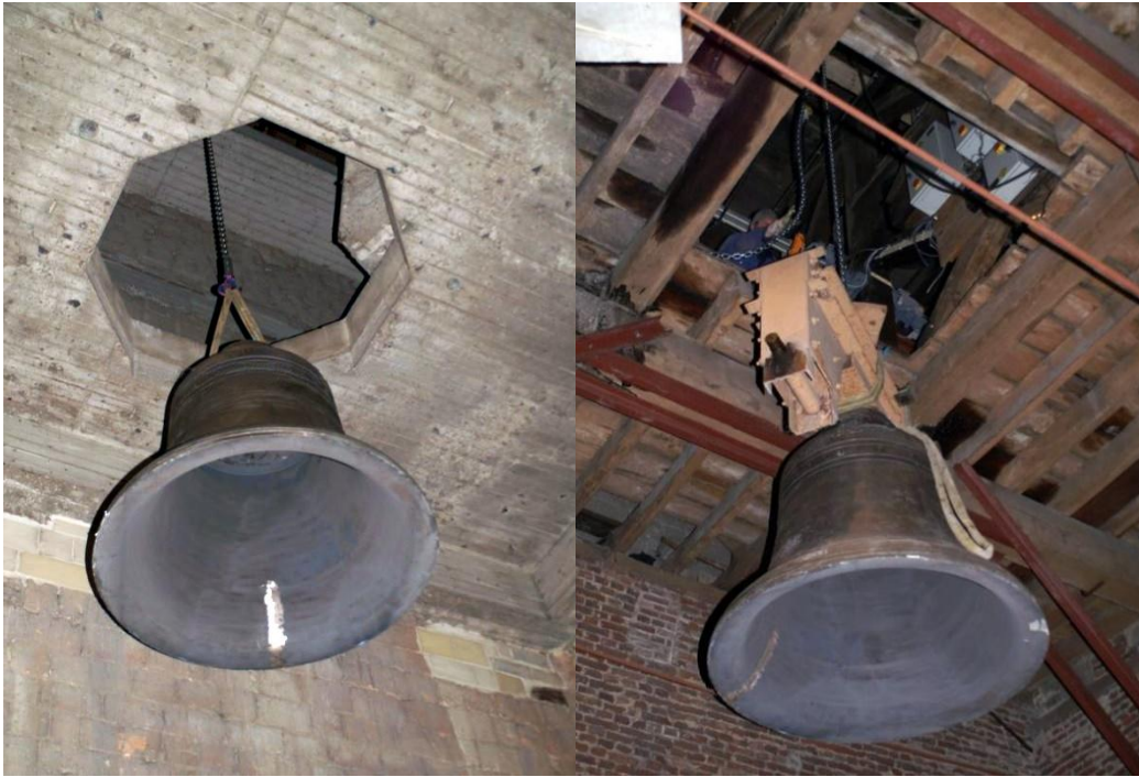
Figuur 79: Opening in het derde plafond en in het vierde plafond (de reparatiestreek is goed te zien)
