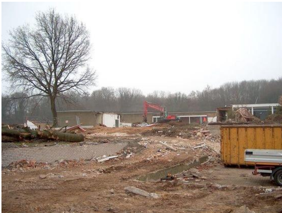
Figuur 70: De andere, niet beschermde beukenbomen, leggen wel het loodje bij de sloop van de Pabo
