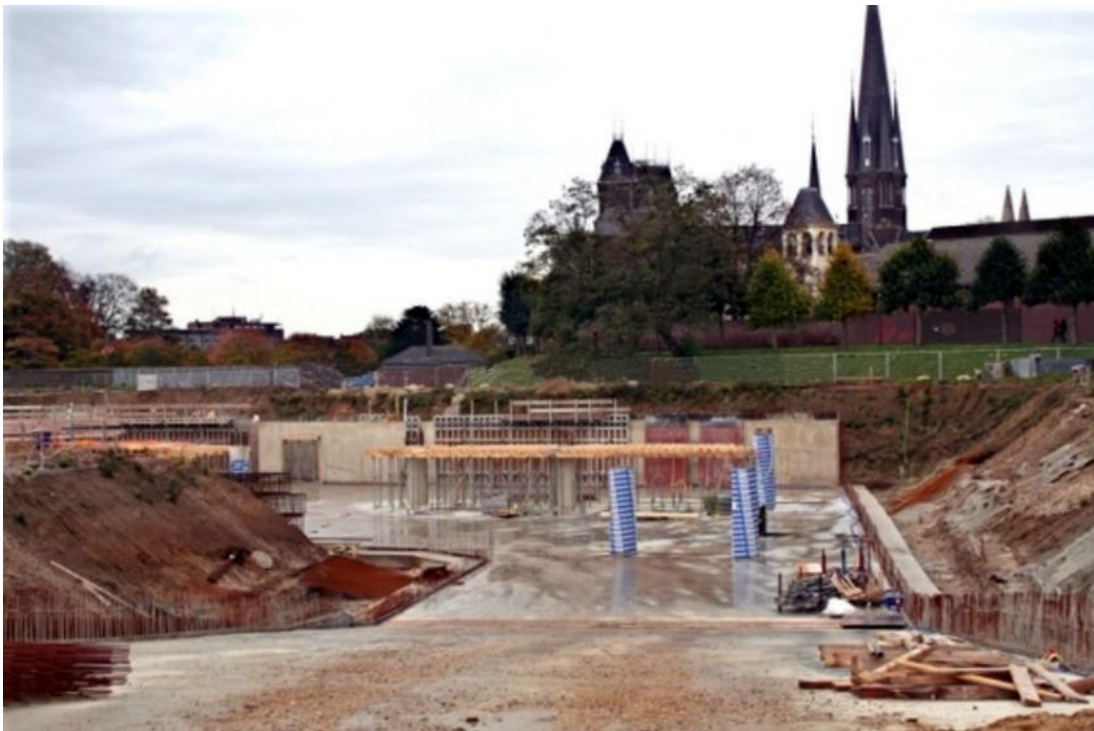
Figuur 109: Bouw van de parkeergarage in de schootsvelden in 2006
