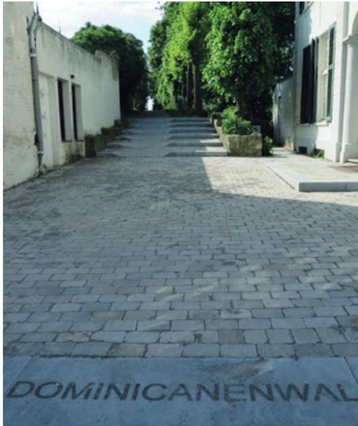
Figuur 193: Vernieuwde opgang naar de Dominicanenwal in de Paardestraat
