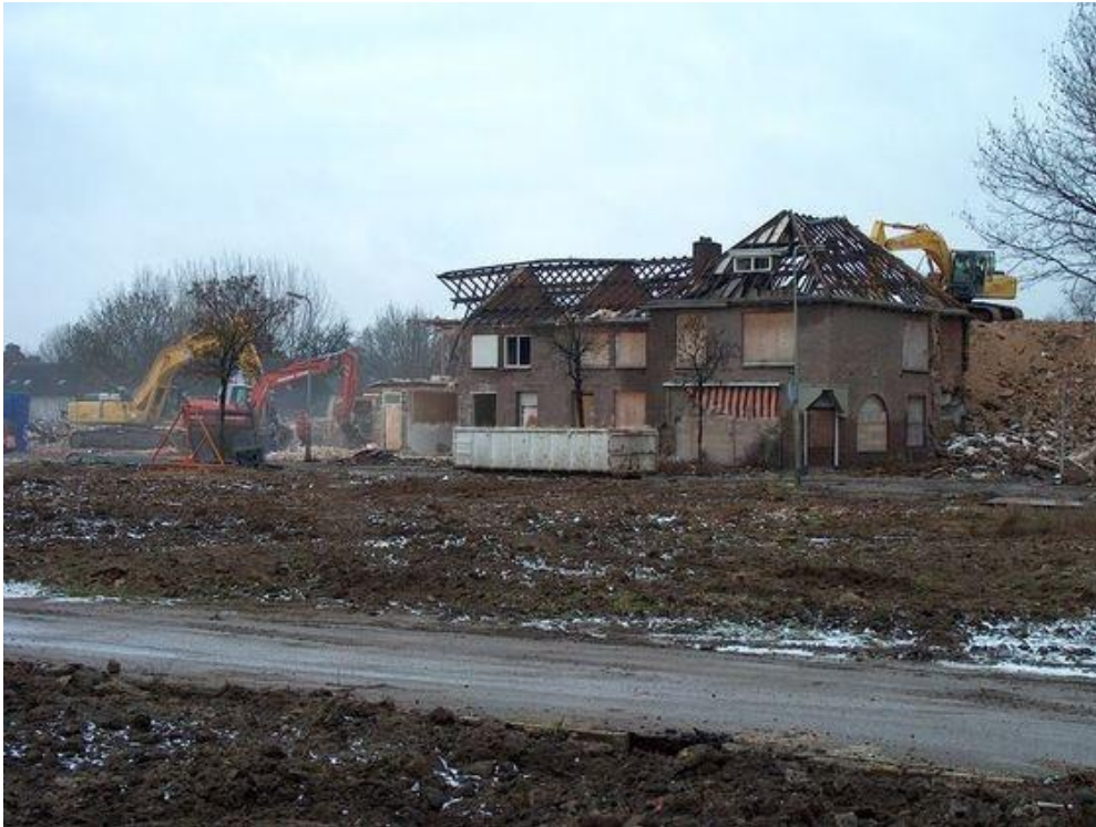
Figuur 97: Het laatste woonblok van de sloopwoningen in de St. Josephstraat Stadtbroek
