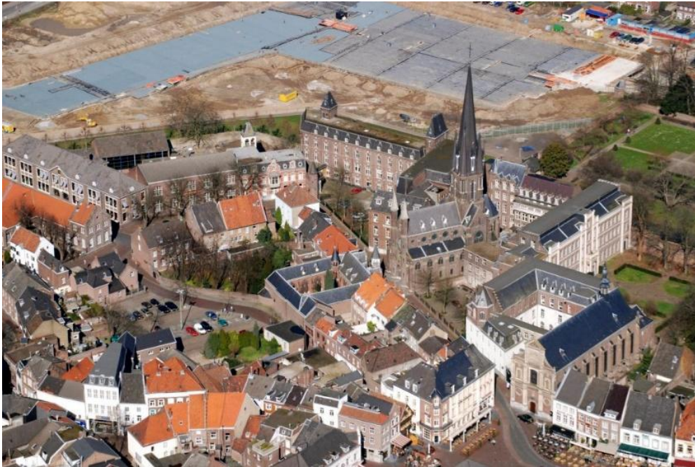
Figuur 110: Bovenaan is de enorme afmeting van de Odaparking goed te zien
