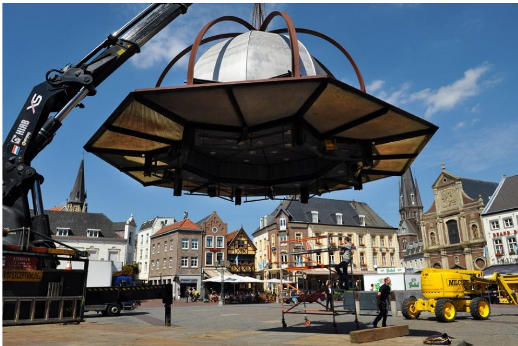
Figuur 174: De kiosk op de Markt uit 1993 wordt afgebroken
