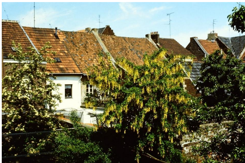
Figuur 201: Achterkant woningen in de Putstraat
