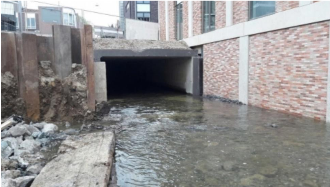
Figuur 89: De betonnen overkluizing van de Keutelbeek wordt weer ongedaan gemaakt
