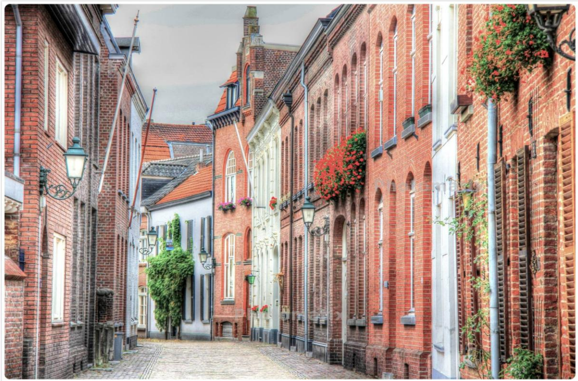
Figuur 205: Woningen in de Begijnenhofstraat ontdaan van portlandcement
