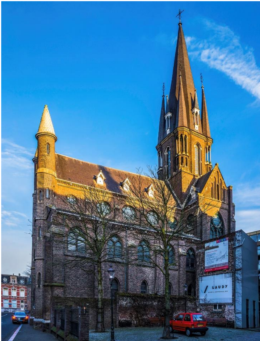
Figuur 182: Aannemer Laudy voert de sloop- en herstelwerkzaamheden bij de Basiliek uit
