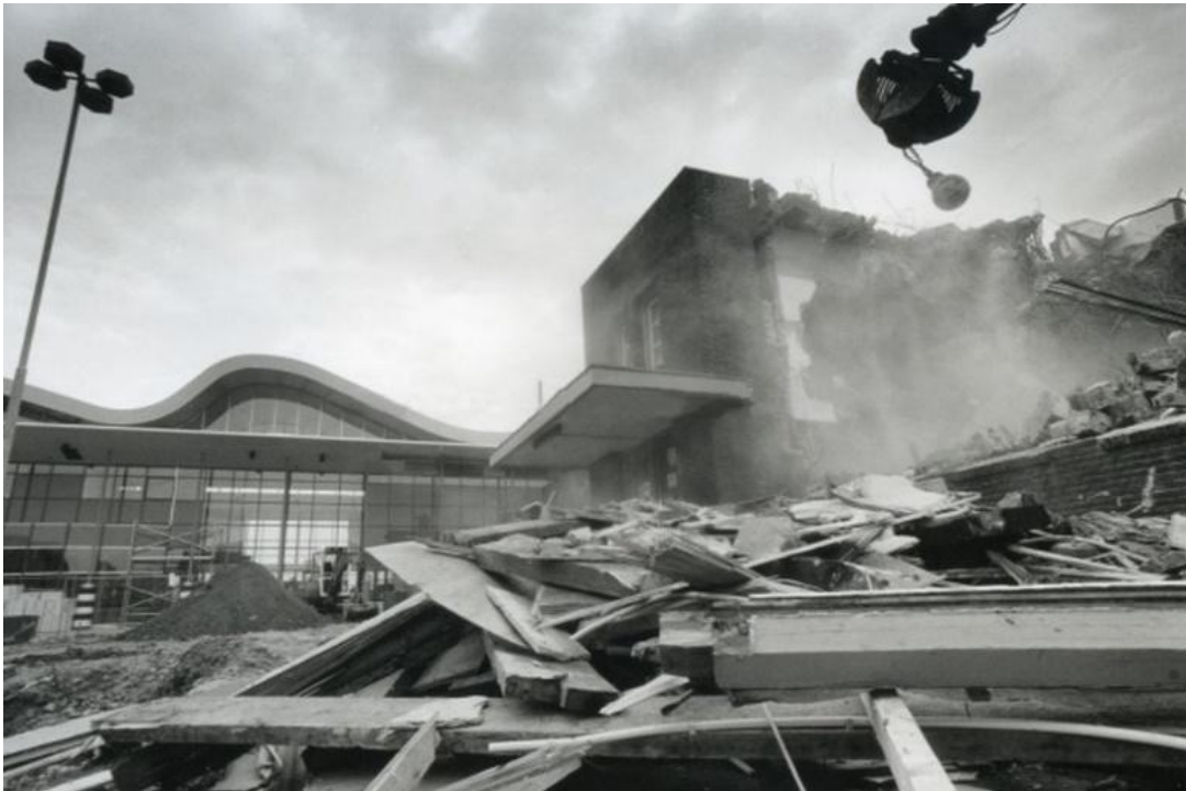
Figuur 18: Sloop van het oude station in 1993
