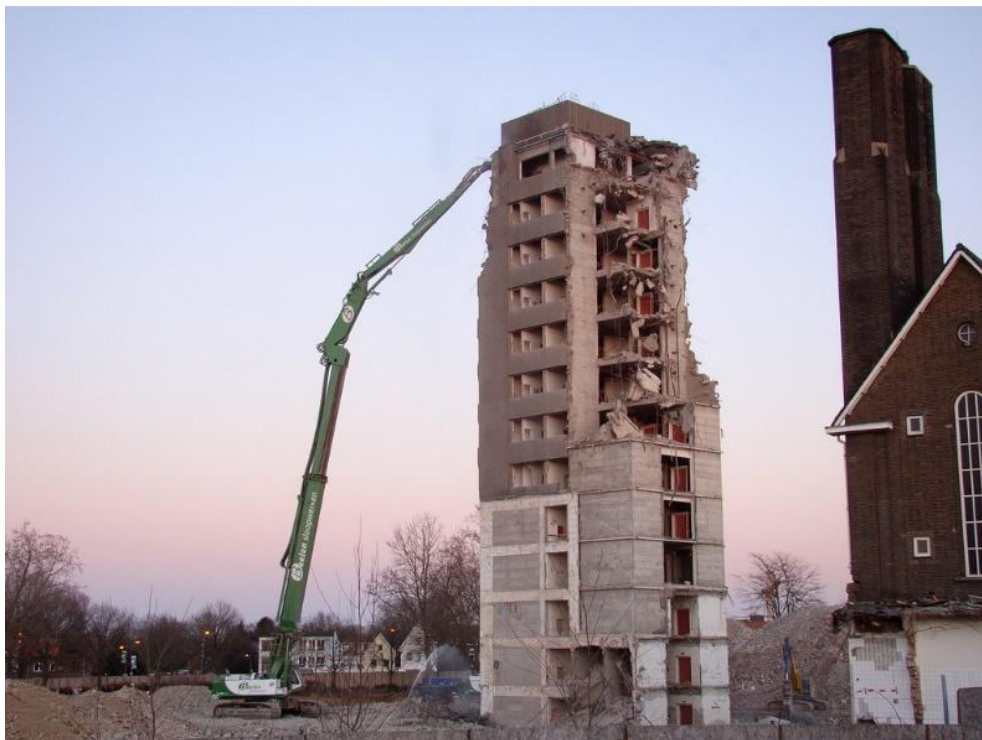
Figuur 128: Als laatste wordt de liftkoker van het ziekenhuis gesloopt
