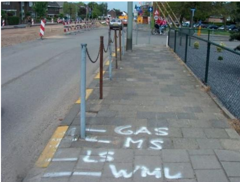
Figuur 93: Aanleg Rijkswegboulevard, met markeringen voor het grondwerk (op foto van Mgr. Vranckenstraat tot Burgemeester Coenderstunnel)
