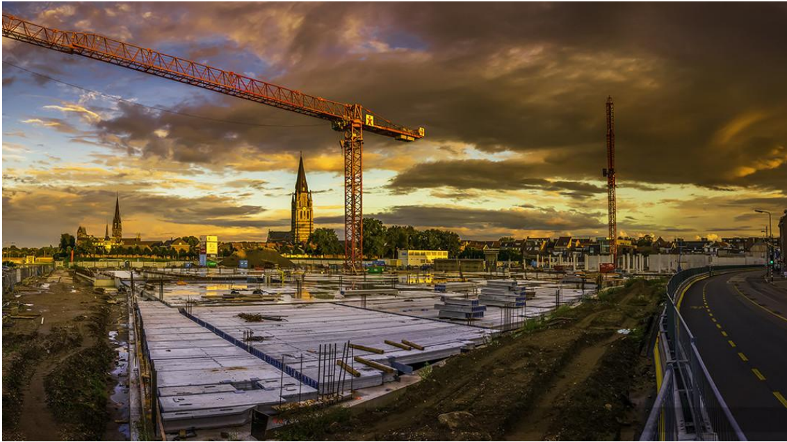
Figuur 187: Bouwproject Ligne is gestart (rechts Rijksweg Noord)
