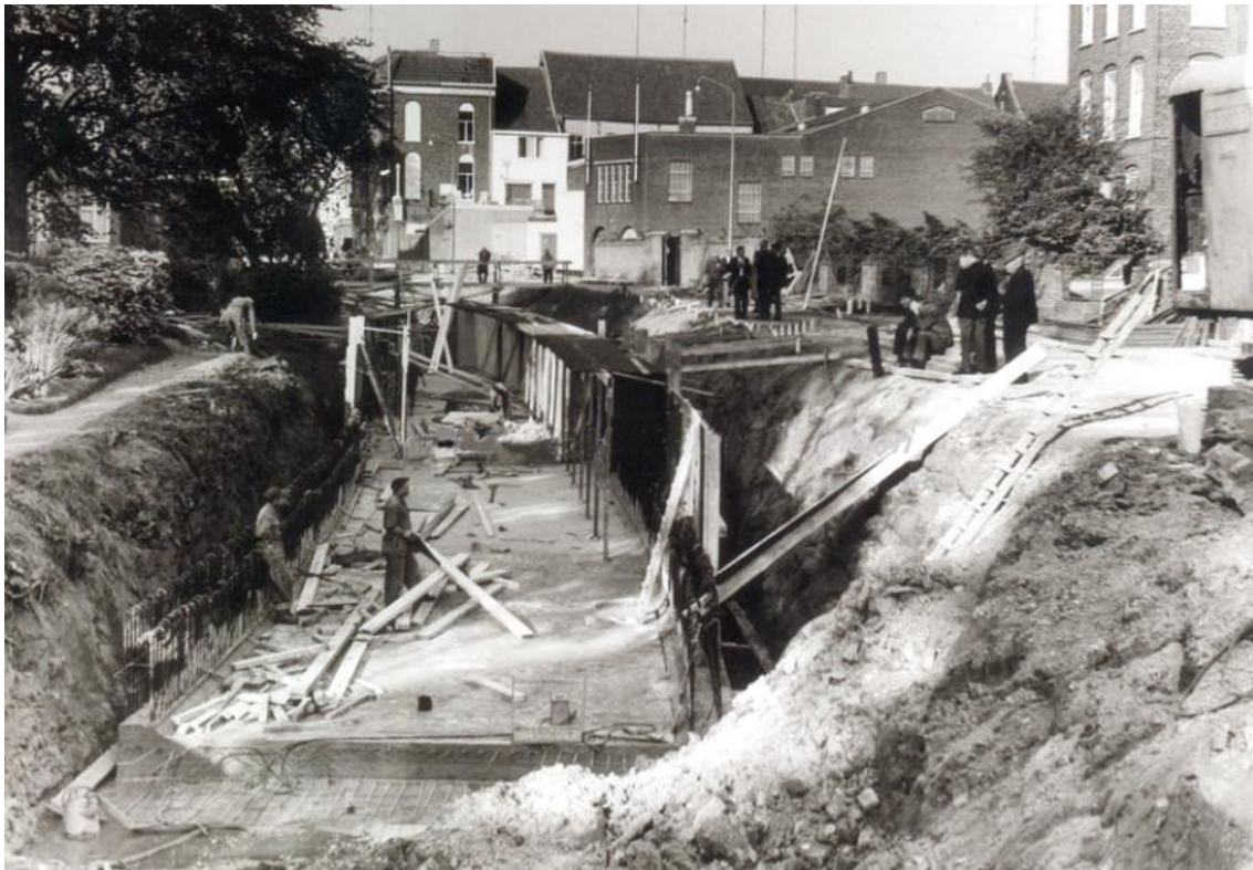
Figuur 86: Overkluizing van de Keutelbeek in de Parklaan voor het Bisschoppelijk College
