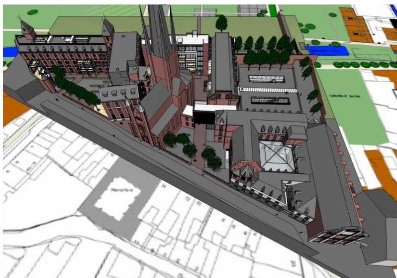
Figuur 180: Het Kloosterkwartier aan de Oude Markt met centraal de Basiliek
