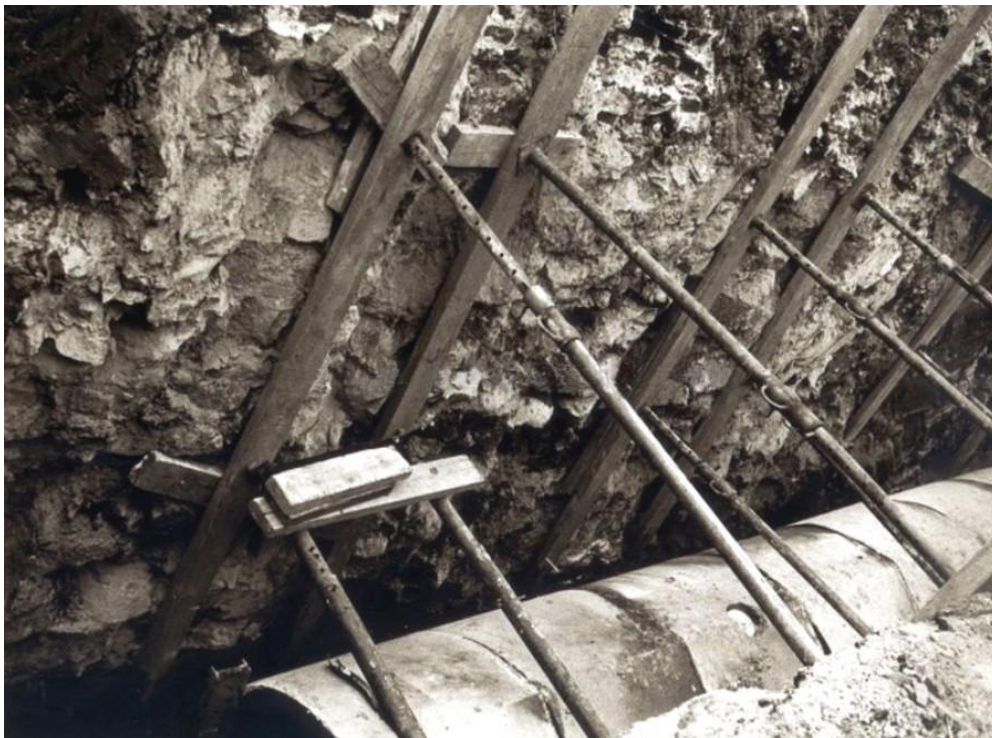
Figuur 84: Overkluizing van de Molenbeek op het Tempelplein
