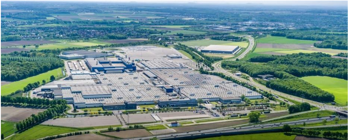
Figuur 57: NedCar met op de achtergrond Nieuwstadt en rechts de bouw van een viaduct onder de Rijksweg
