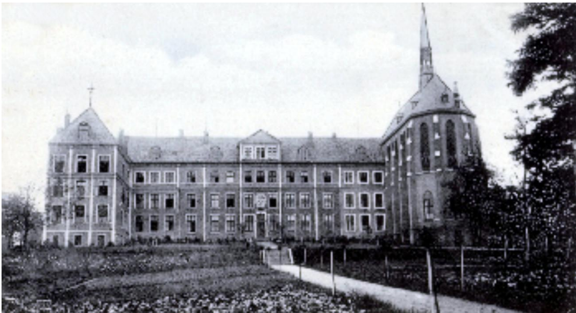
Figuur 97: Verbouwde kasteel Watersleij in 1902
