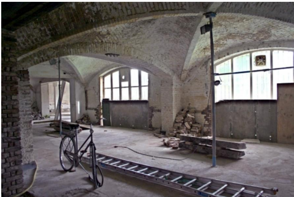
Figuur 68: Boogvormige keldergewelven van het Ursulinenklooster onder de Dominicanenwal
