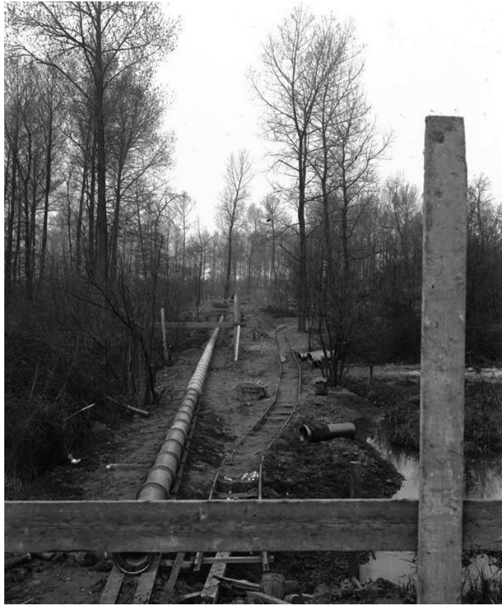
Figuur 354: Aanleg pijpleiding van roeivijver naar Geleenbeek
