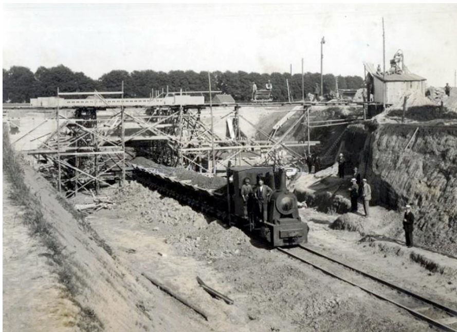
Figuur 369: Bij de aanleg van de tunnel wordt een eigen spoorweg gebruikt in 1925
