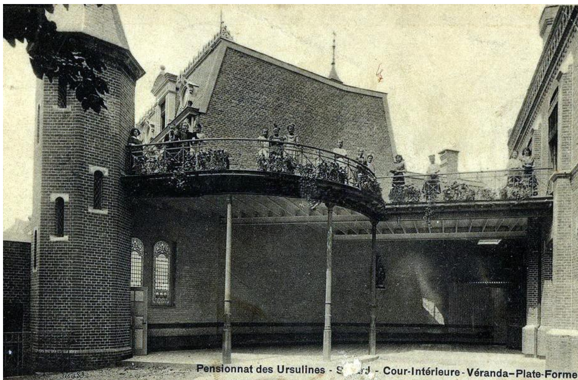
Figuur 253: Traptorentje en platform geven toegang tot het pensionaat
