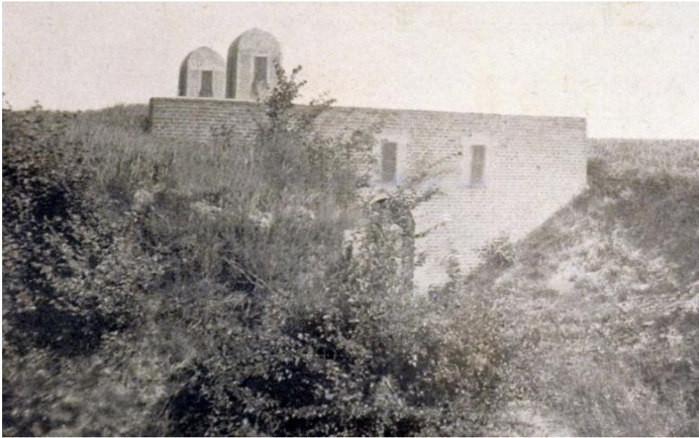
Figuur 196: Waterreservoir aan de Duustergats op de Kollenberg
