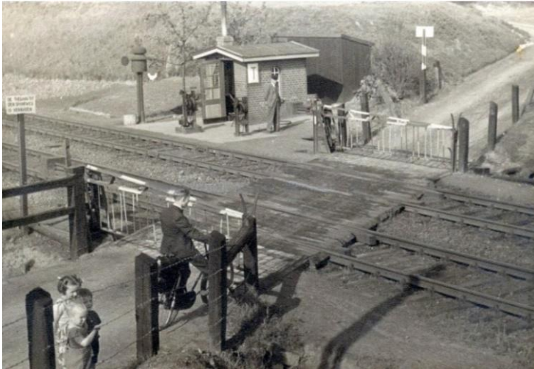
Figuur 374: Spoorwegovergang in Sanderbout voor de elektrificatie
