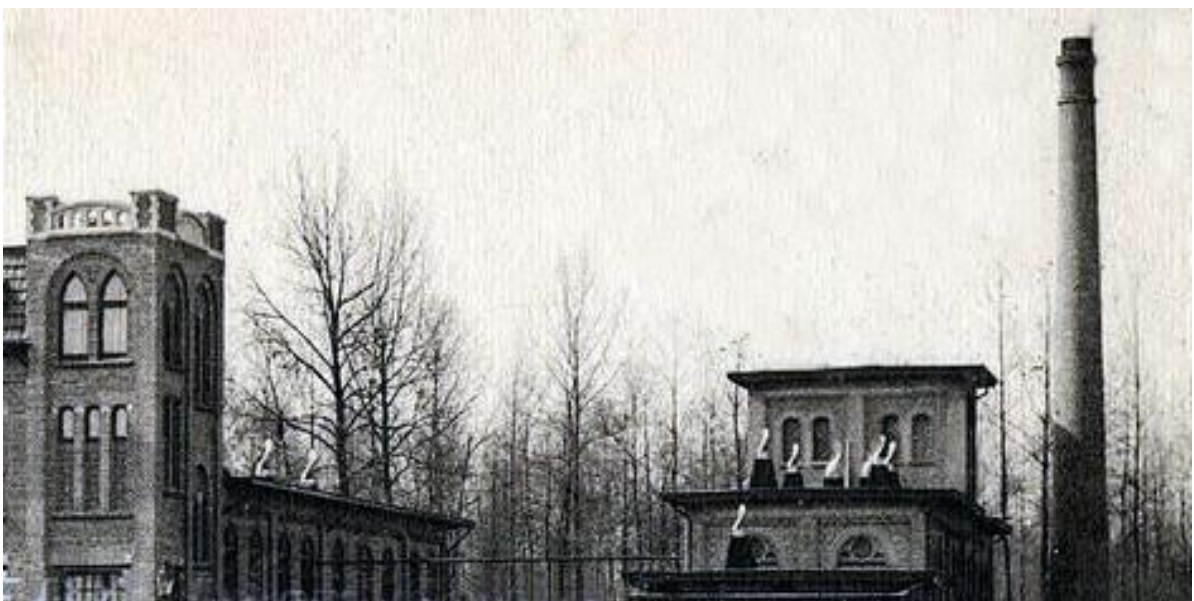
Figuur 184: Moderne windaangedreven afzuiging op het dak van het slachthuis
