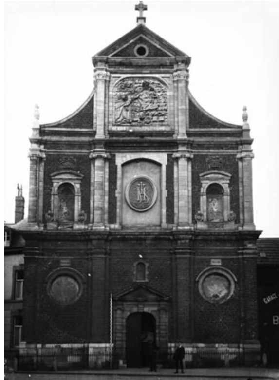
Figuur 52: Dichtgemetseld venster boven de ingang van de St. Michielskerk
