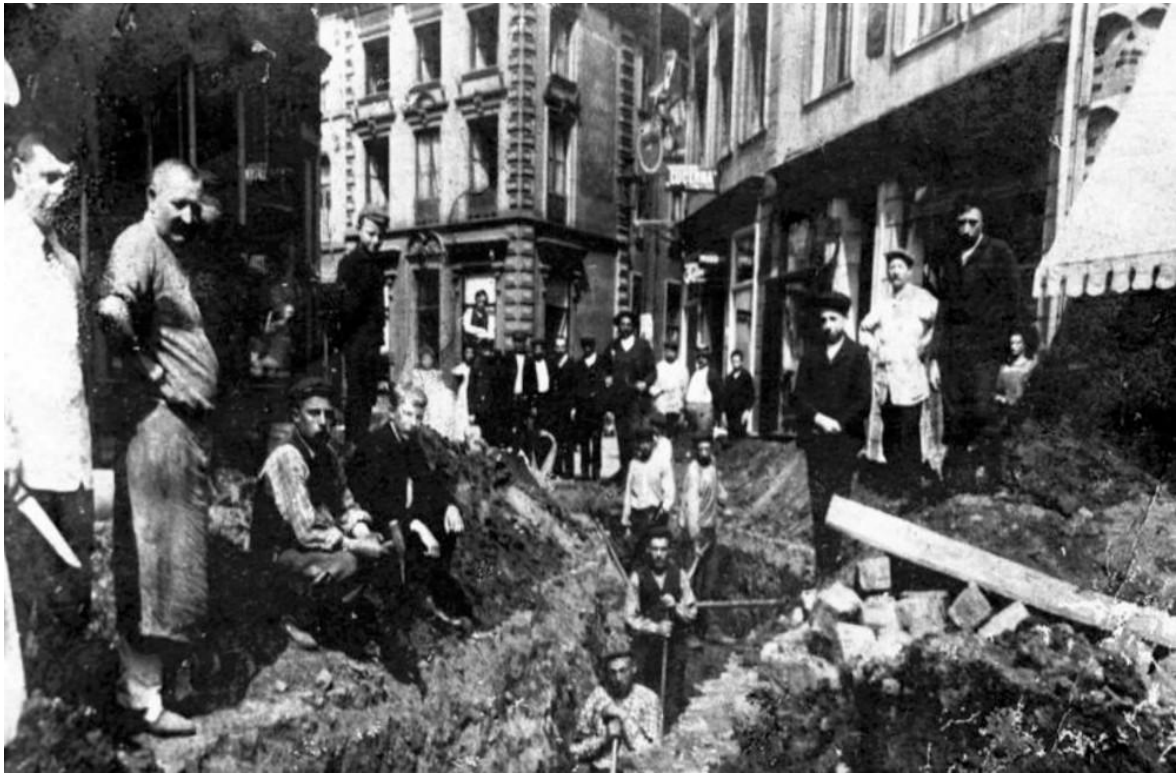
Figuur 192: Riolering wordt aangelegd in de Limbrichterstraat in 1910
