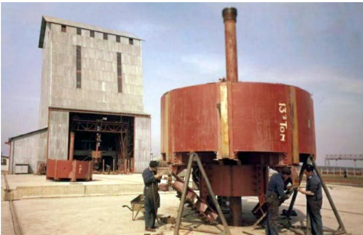
Figuur 136: Boorkop waarmee de schacht van de Beatrixmijn aangelegd wordt, op de achtergrond de boortoren in 1957
