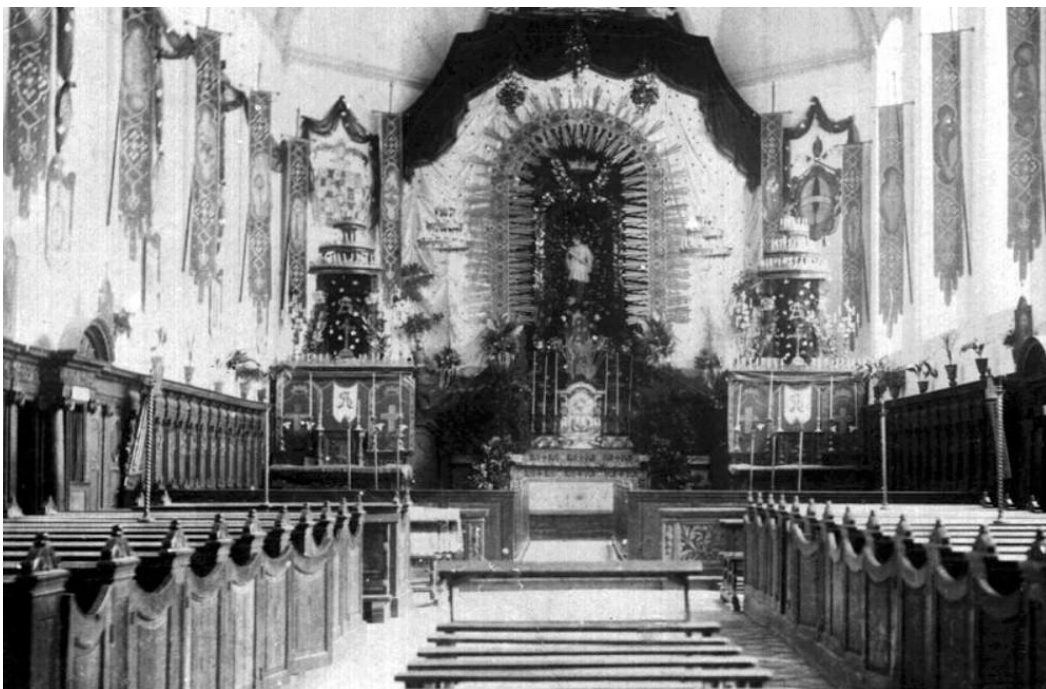
Figuur 331: Gasverlichting is vervangen door elektrisch licht in de druk versierde St. Michielskerk
