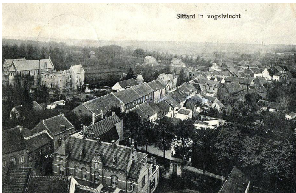
Figuur 214: Linksboven het Bisschoppelijk College, onder het postkantoor, rechts de bomenrij van de Begijnhofwal in 1912
