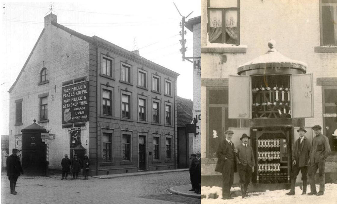
Figuur 274: Links een rond transformatorhuisje hoek Rijksweg Noord-Voorstad, met geopende zekeringenkast
