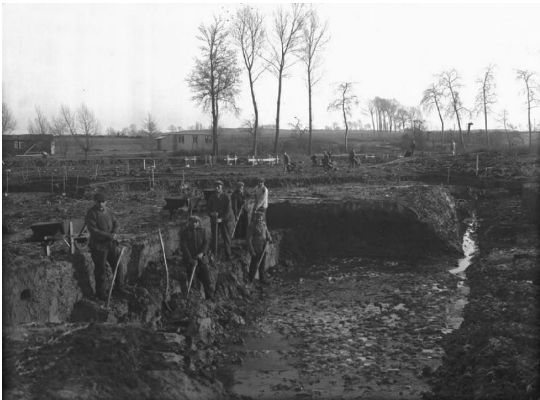
Figuur 351: Na het rooien van het Elzenbroekbos wordt met de hand de vijver uitgegraven
