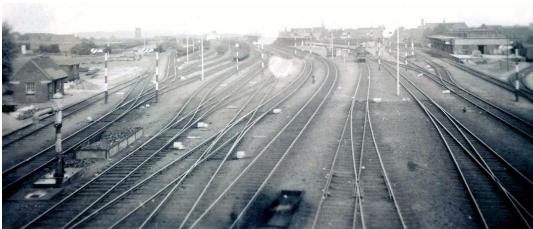
Figuur 372: Het nieuwe rangeerterrein in 1930 (Links onderaan een waterpomp voor het bijvullen van de stoomlocomotieven. De bak daarboven voor het lossen van de sintels uit de vuurkist van de stoomlocs)
