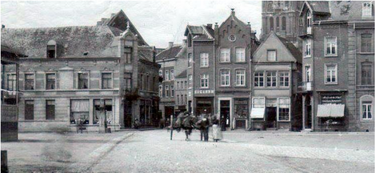
Figuur 113: Links kledingwinkel in 'Mantels, Pelsen, Stoffen' rond 1910 en de stadspomp
