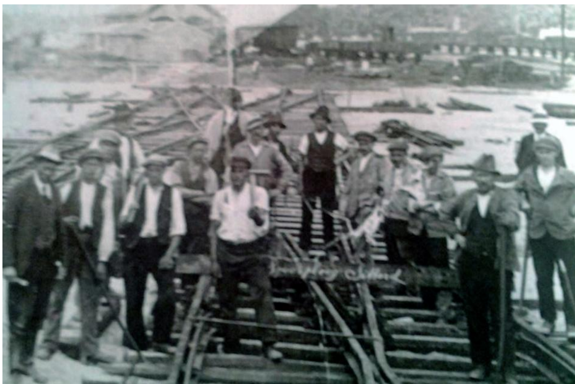
Figuur 366: 'Spoorploeg Sittard' bezig met het aanleggen van het rangeerterrein bij het station
