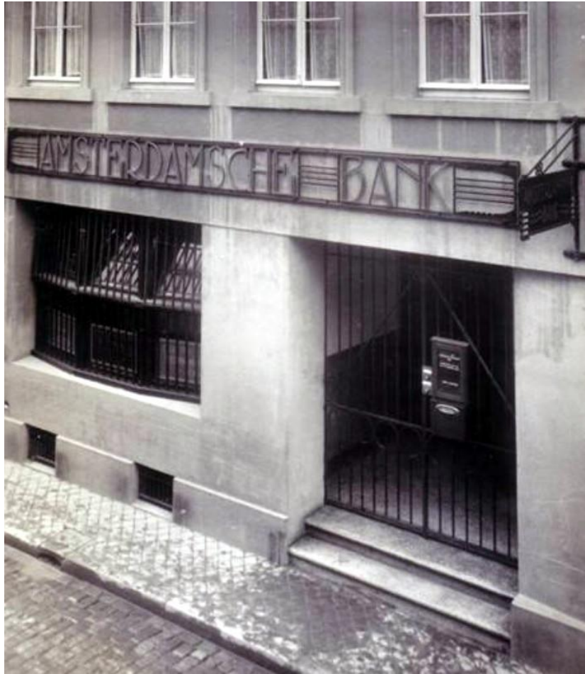
Figuur 294: Amsterdamse Bank in de Brandstraat 1920
