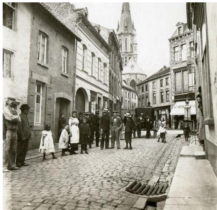
Figuur 193: Riolput in de Molenbeekstraat 1910 (Op de hoek met de Limbrichterstraat staat nog een stadspomp, daarvoor heeft de eigenaar van het stoepje deze onbegaanbaar gemaakt door er beugels op de plaatsen)
