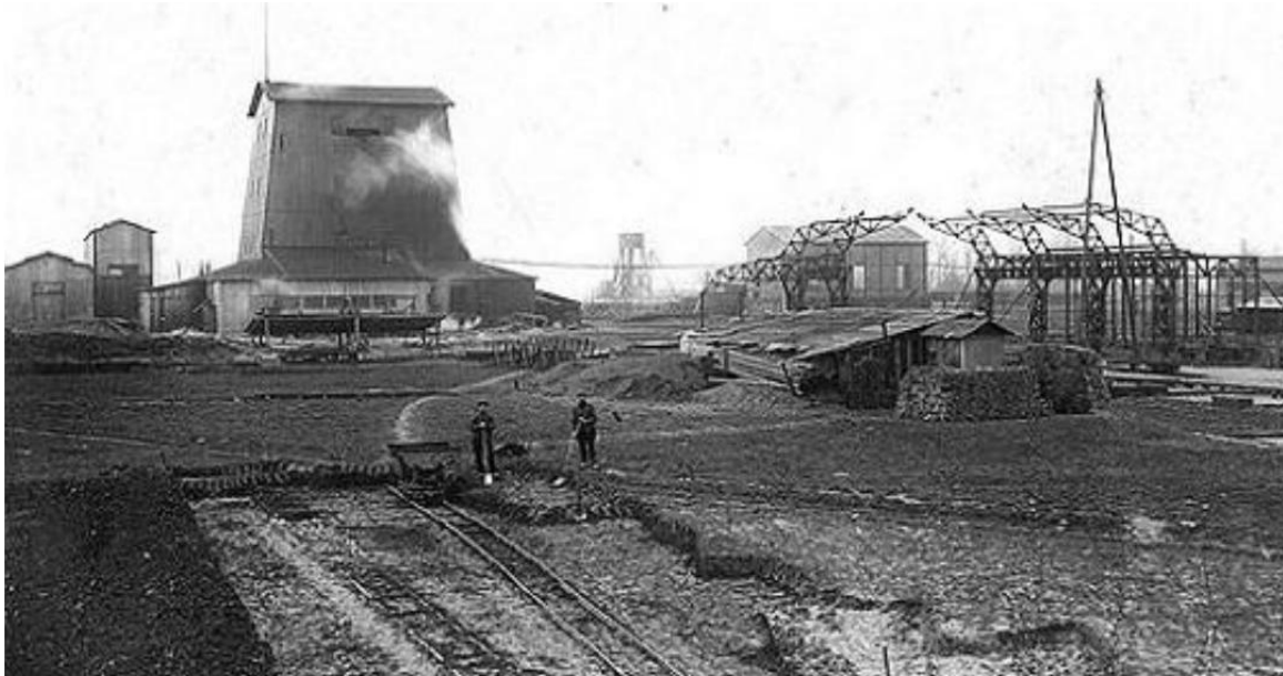
Figuur 267: De eerste schacht wordt pas aangelegd in 1919
