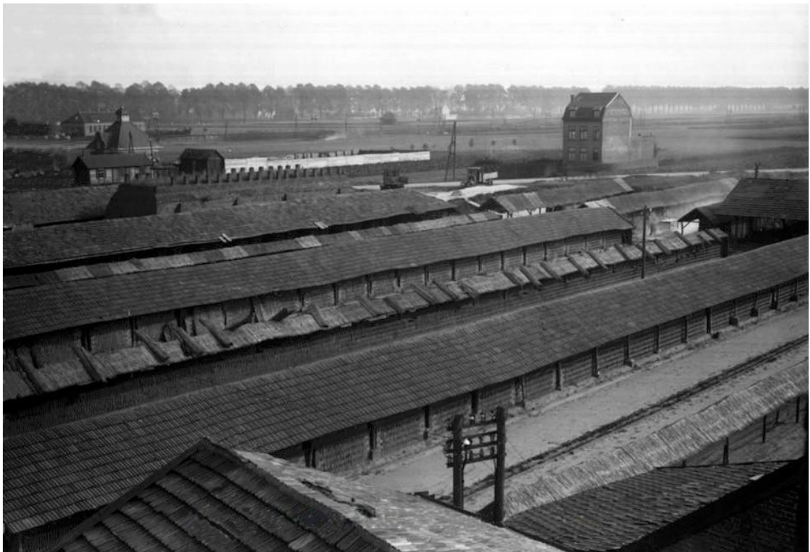
Figuur 365: Steenfabriek die gesloopt wordt voor de aanleg van het rangeerterrein bij het station
