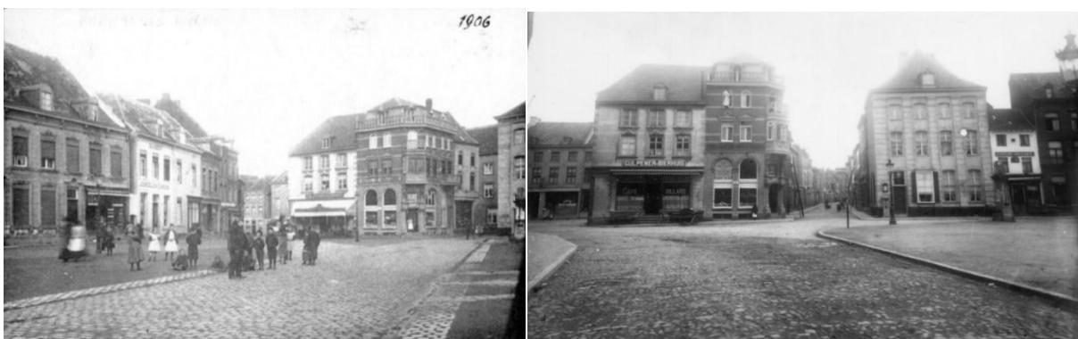
Figuur 335: De straat over de Markt is verlegd naar de zijkant
