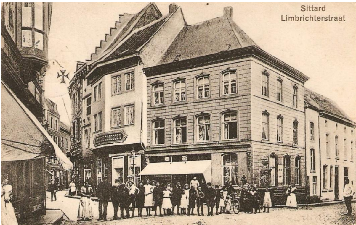
Figuur 264: Waterpomp hoek Limbrichterstraat – Molenbeekstraat wordt afgebroken
