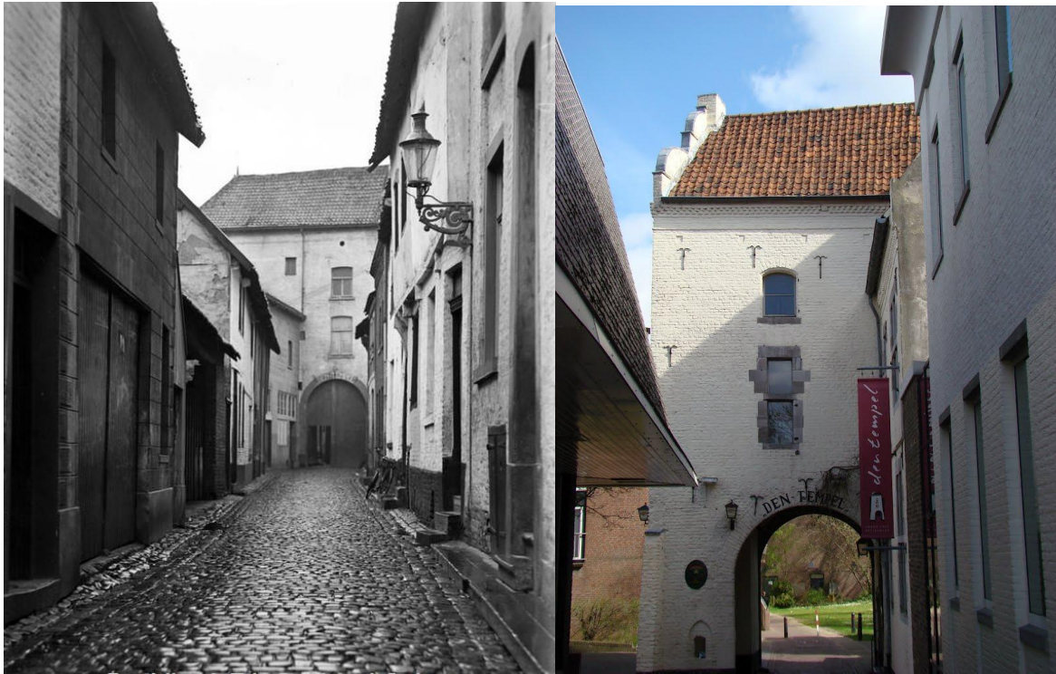
Figuur 63: De toegangspoort van boerderij den Tempel na renovatie uitgevoerd als een soort stadspoort.
