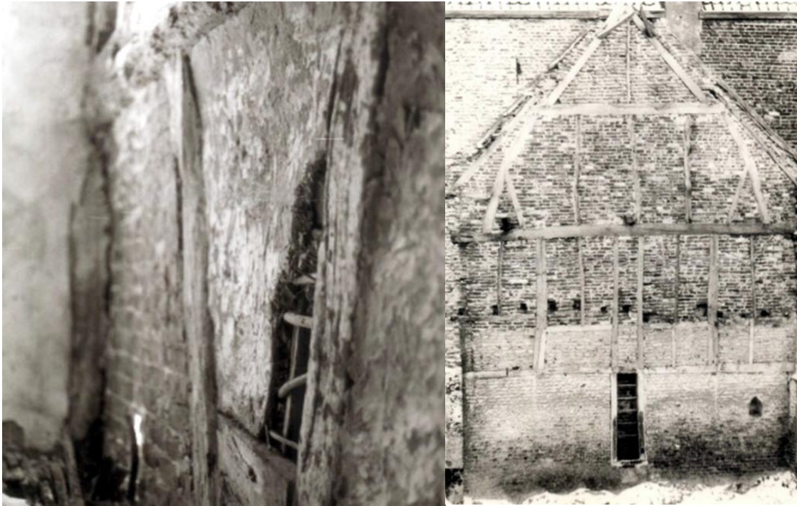
Figuur 20: Bij de sloop van woningen in de Helstraat in 1970 blijken enkele binnenmuren nog van leem gemaakt te zijn. In latere jaren werden de lemen delen vervangen door bakstenen tussen het houten vakwerk, zoals bij de sloopwoning uit de Helstraat te zien is
