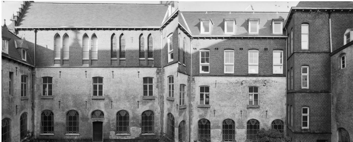
Figuur 70: Dominicanerklooster- binnenplaats naar het noorden en binnenplaats naar het oosten (ankerjaartal 1657)
