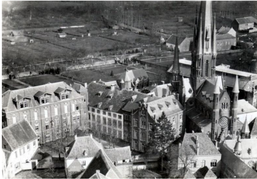
Figuur 318: In 1871 is links van het hoofdgebouw (het oude Huis op de Berg) een nieuwe internaat vleugel gebouwd
