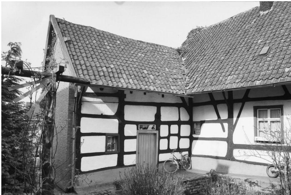
Figuur 176: Vakwerkboerderij in Einighausen
