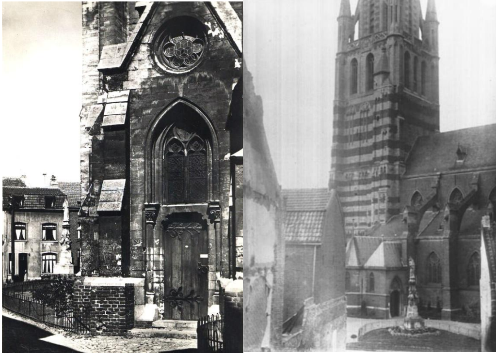
Figuur 364: Vroegere kerkingang aan de oostkant in 1922 en de huidige ingang aan de zuidkant
