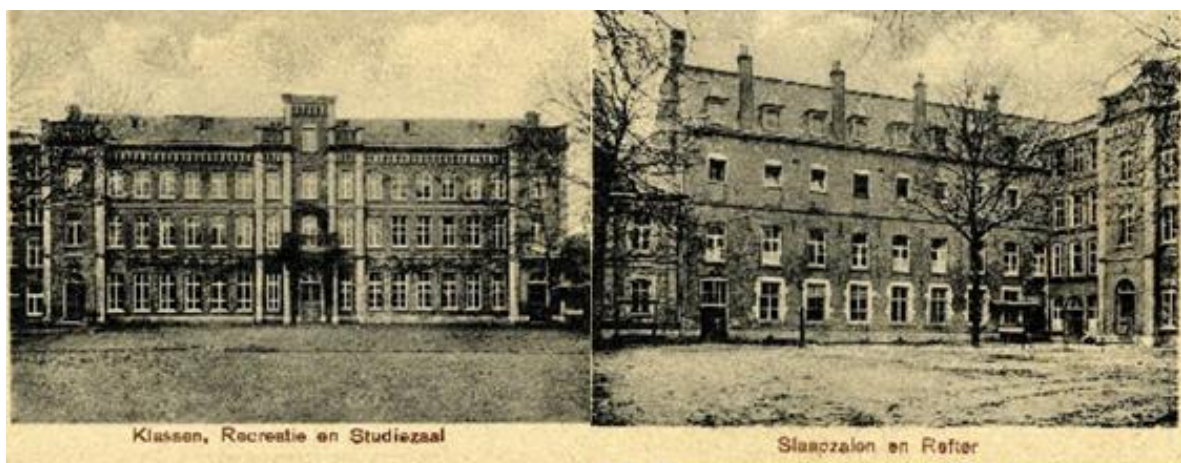
Figuur 303: St. Aloysiuscollege van de Jezuïeten in het voormalige Dominicanenklooster
