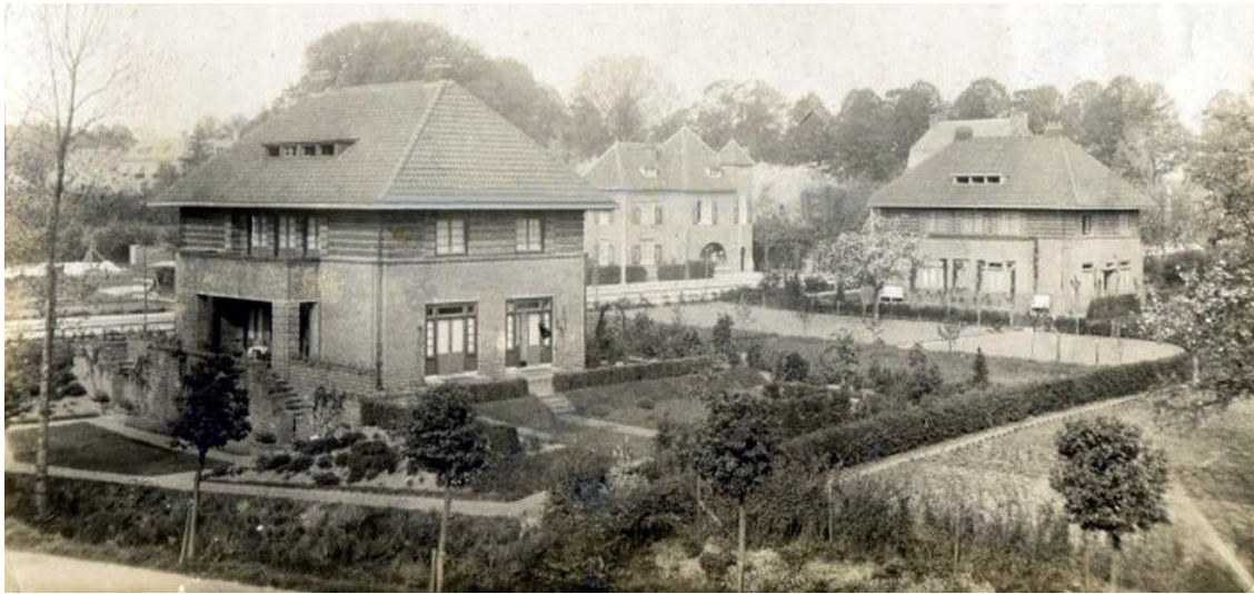
Figuur 22: Op achtergrond de winkel 'de Coöperatie' aan de Wilhelminastraat (de twee huizen op de voorgrond zijn afgebroken)
