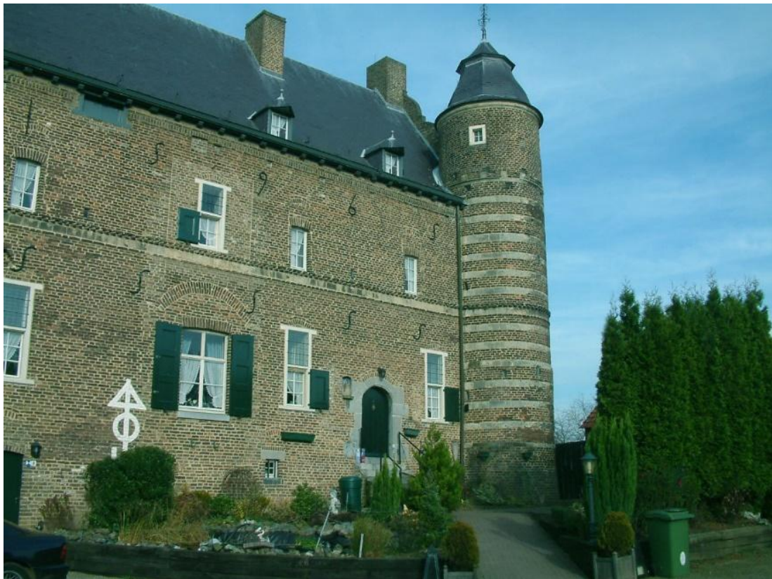
Figuur 333: Ankerjaartal 1596 op de voorgevel van het gerestaureerde kasteel Grasbroek
