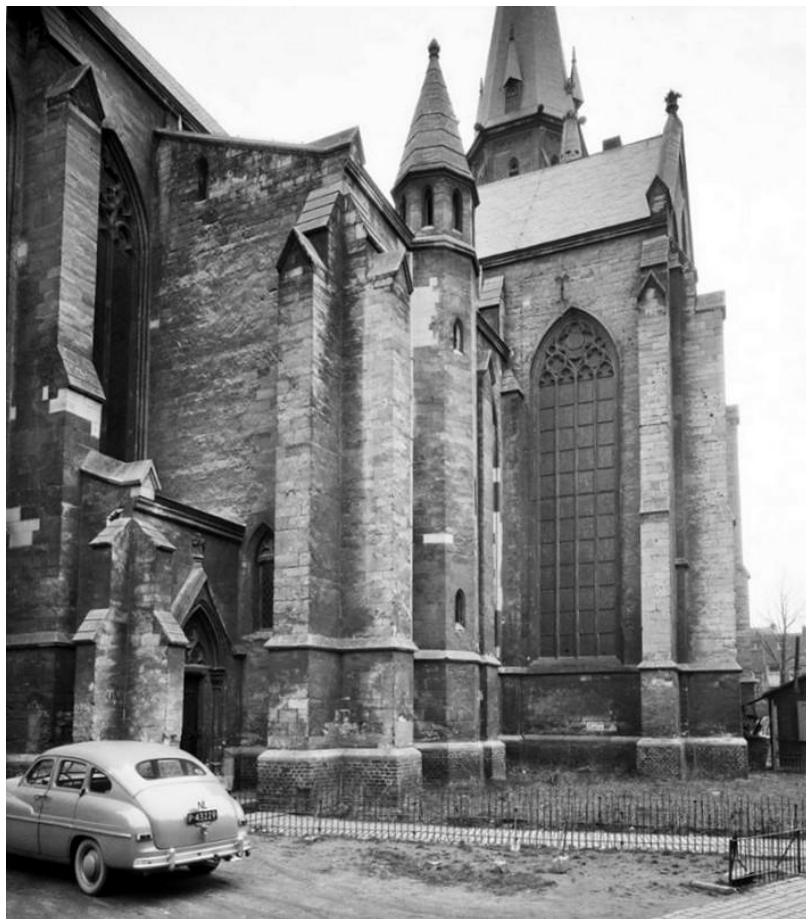
Figuur 45: Vroegere ingang naar het koor, hier wordt de nieuwe sacristie gebouwd
