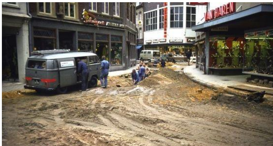
Figuur 255: Aanleg Promenade in de Limbrichterstraat
