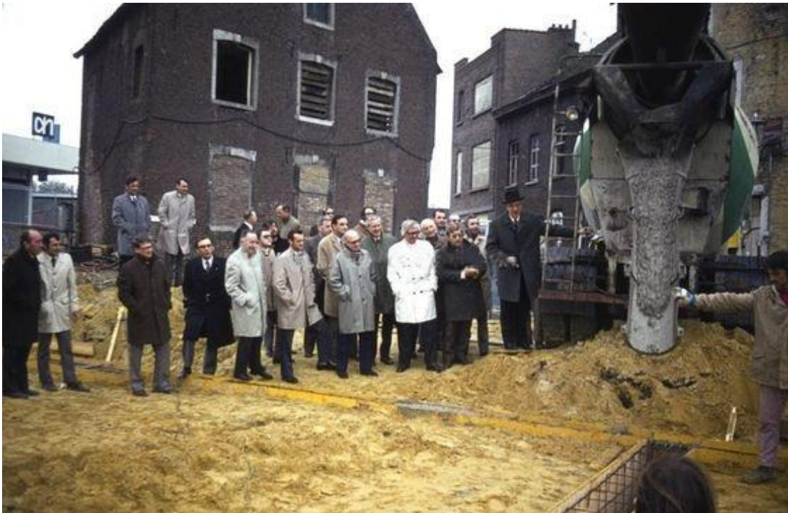
Figuur 253: Burgemeester Dassen stort het eerste beton (op achtergrond het Wijnhuis in de Helstraat)
