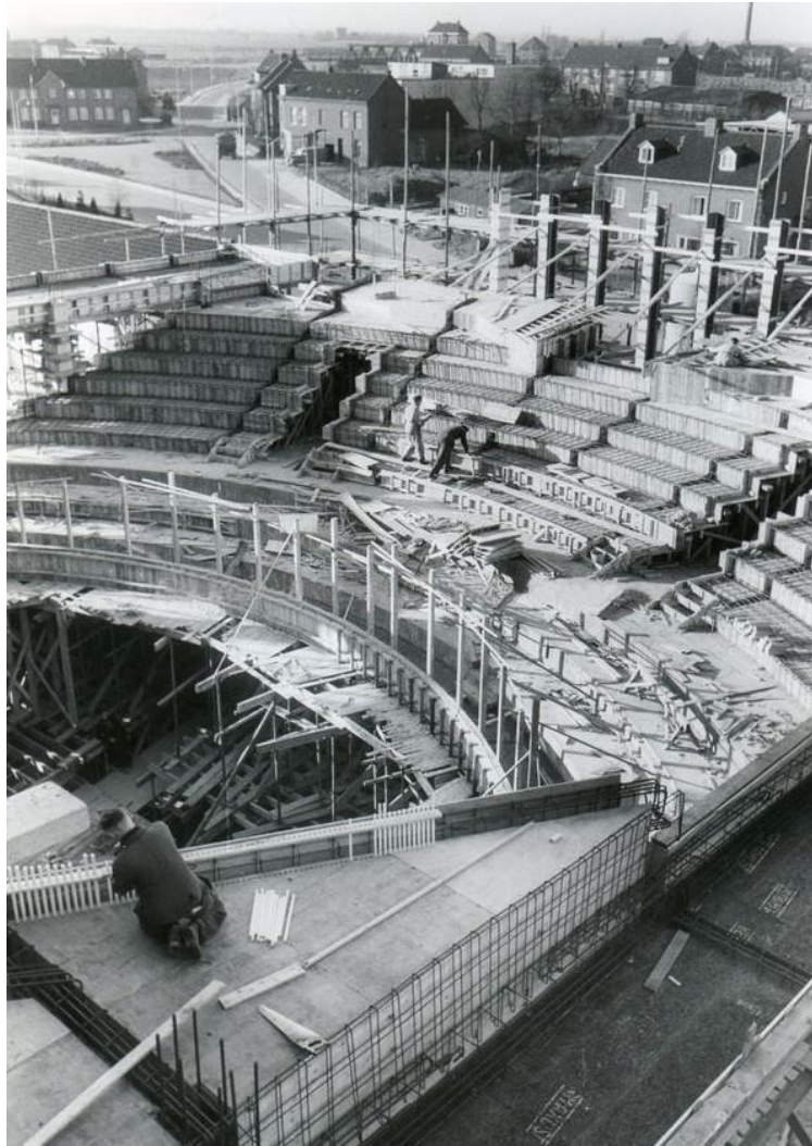
Figuur 54: Het balkon van de schouwburg in aanbouw. Op de achtergrond zichtbaar het Stadswegske
