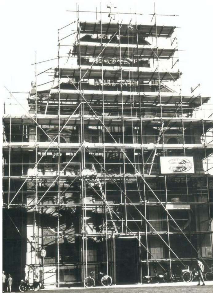
Figuur 162: Restauratie voorgevel St. Michaelskerk
