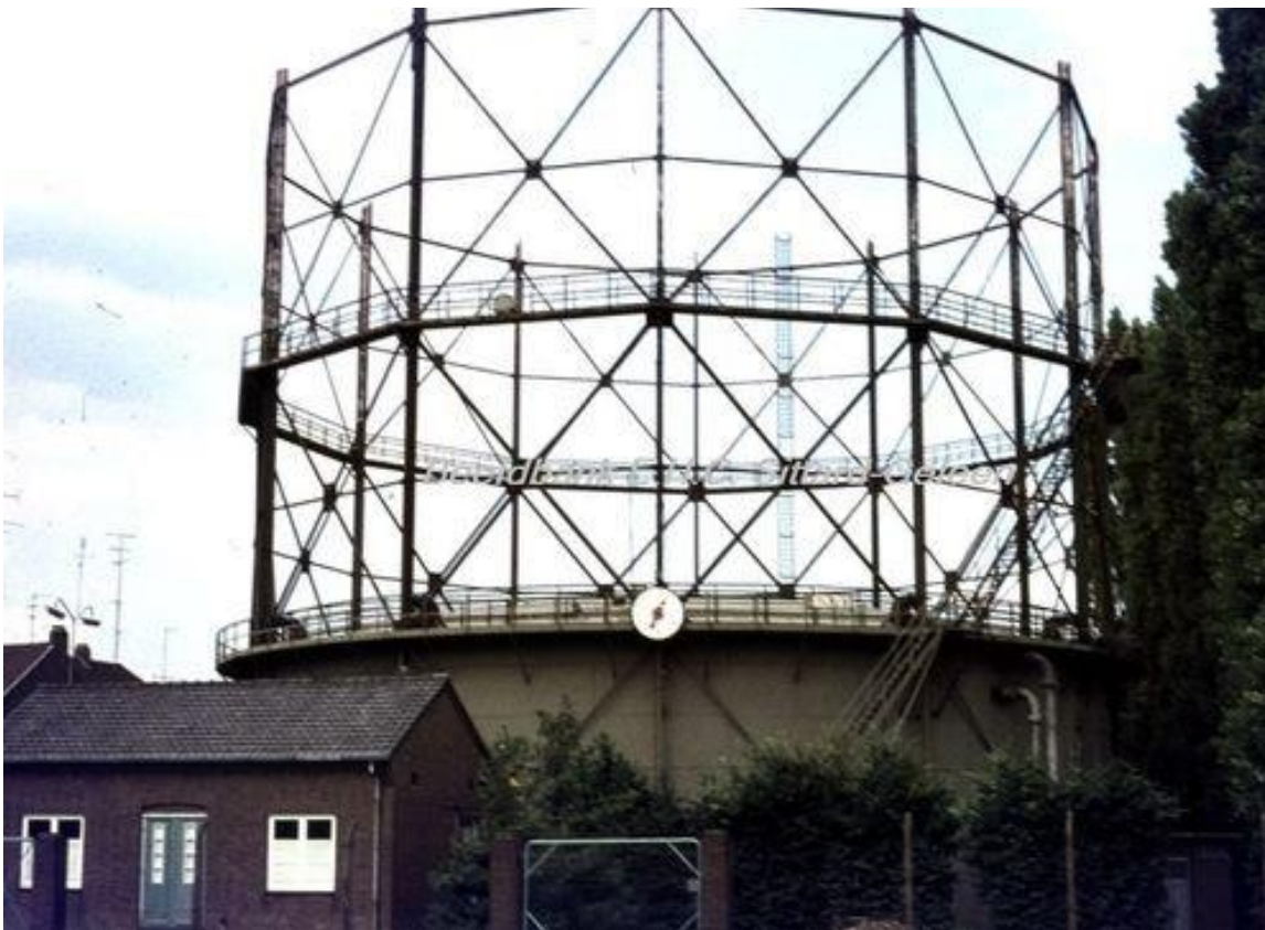
Figuur 216: Oude gasketel aan de Agnetenwal achter de flats aan de Rosmolenstraat
