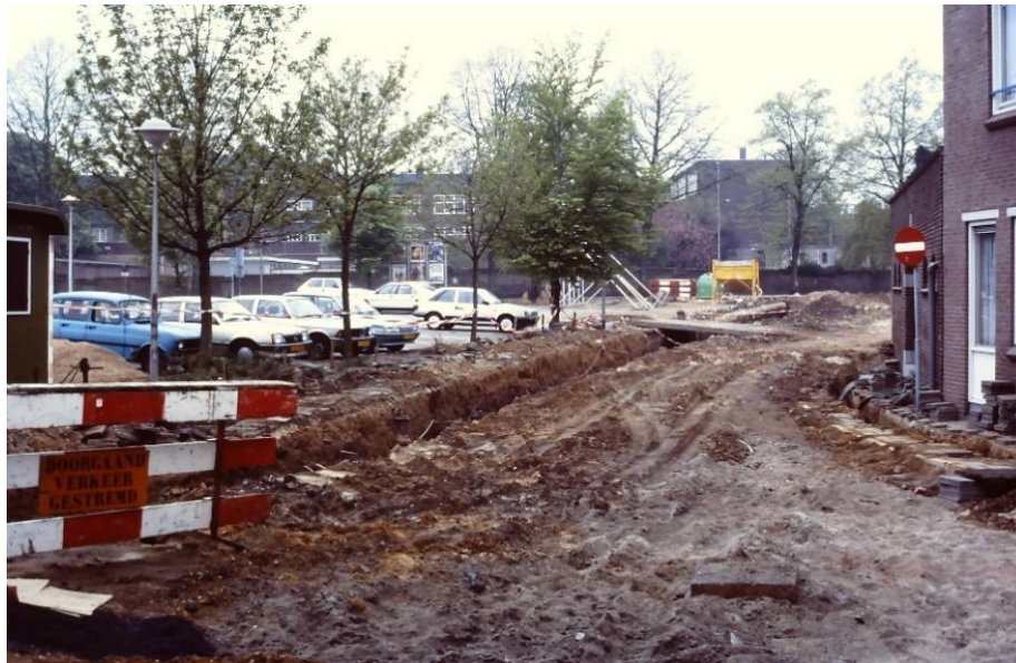
Figuur 3: Hetzelfde parkeerterrein op de oude stadsgracht vanuit de Helstraat, hoek Paradijsstraat 1970
