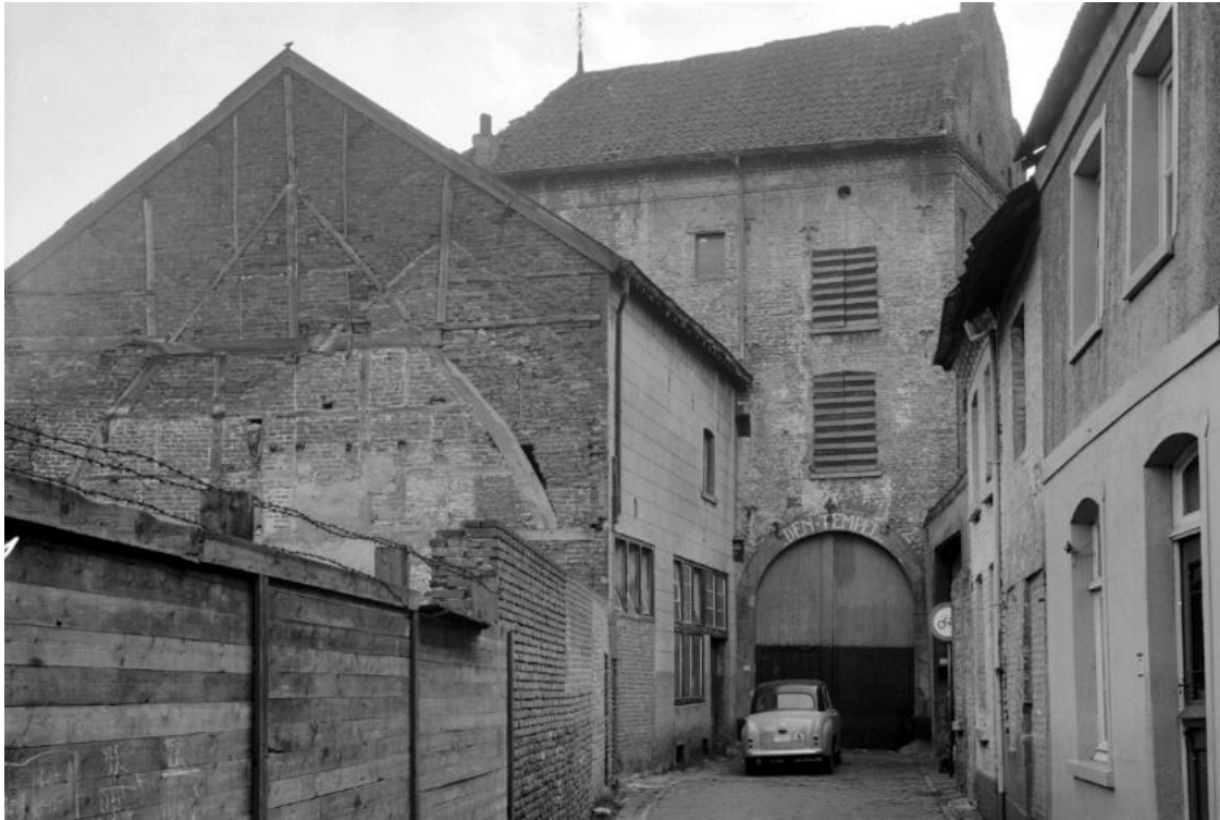
Figuur 85: Verpaupering in de Gruizenstraat
