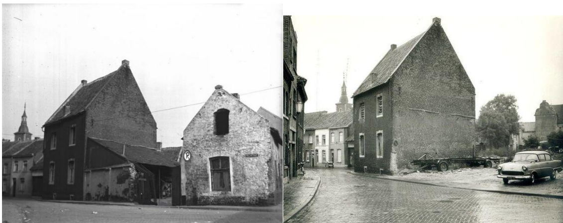
Figuur 172: Woning hoek Helstraat-Paradijsstraat in 1965 onbewoonbaar en in 1970 gesloopt
