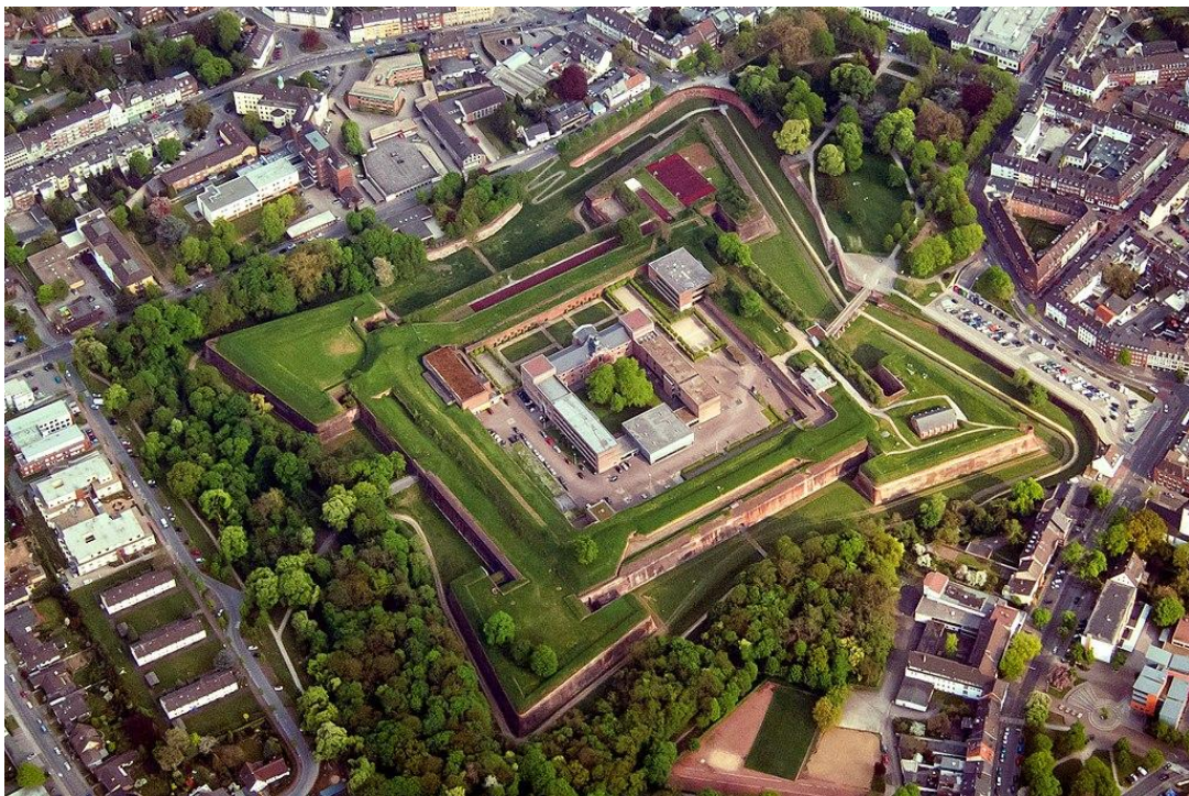
Figuur 111: Citadel van Gulik herbouwd als gymnasium
