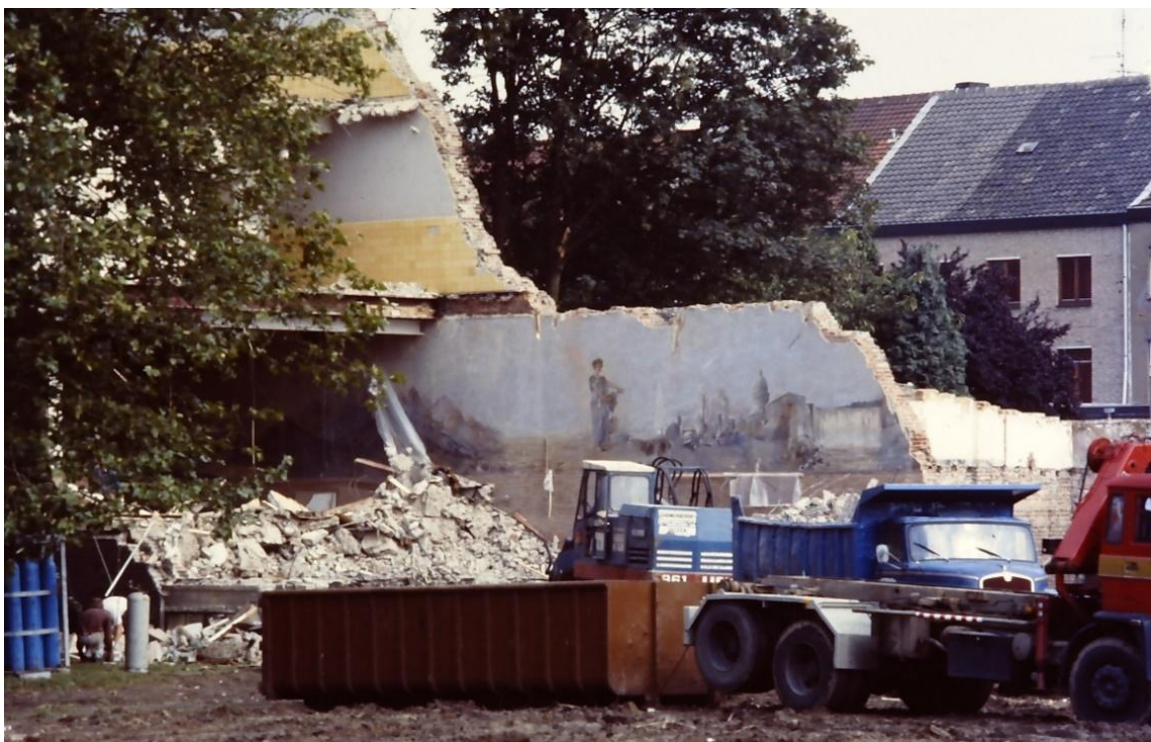
Figuur 341: Muurschilderingen tijdens de sloop van gymzaal en leslokalenvleugel van het College
