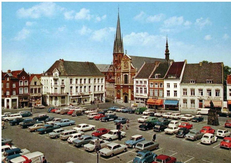
Figuur 92: De kiosk uit 1910 werd in 1961 gesloopt en het marktplein als parkeerplaats ingericht
