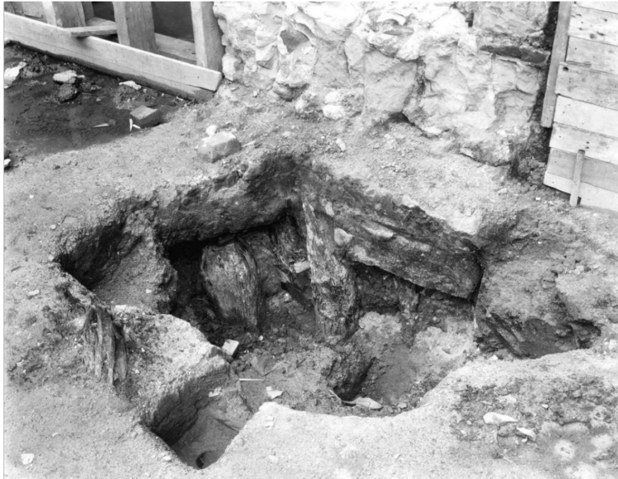
Figuur 48: De kerk blijkt gefundeerd op veldkeien en houten palen
