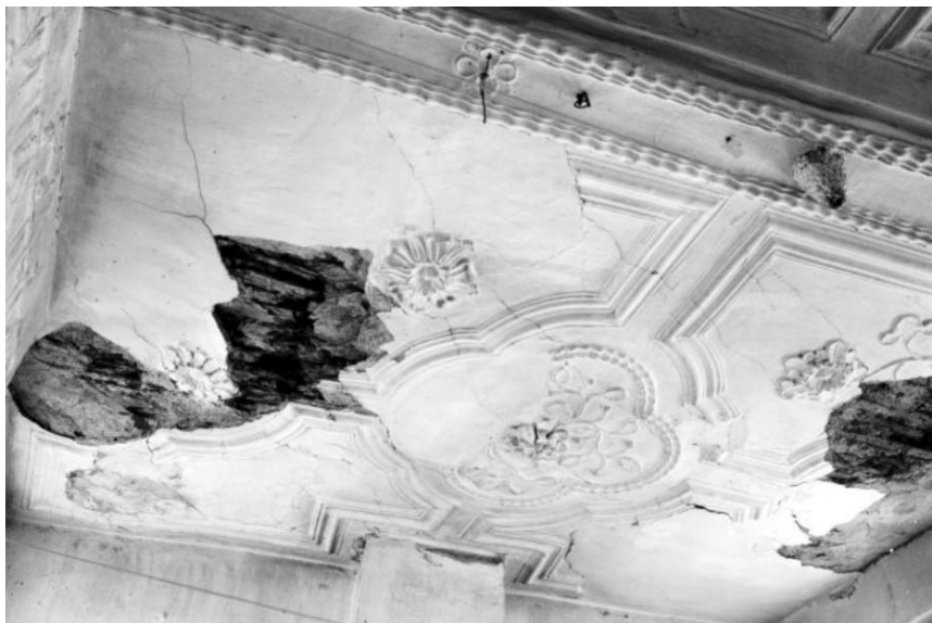
Figuur 100: Stucwerk op het plafond van de oude synagoge
