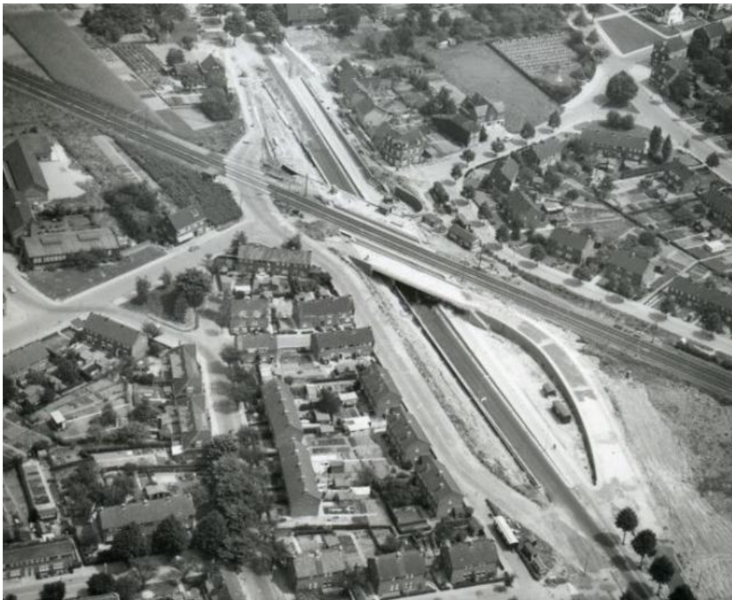
Figuur 80: Aanleg tunnel bij de spoorwegovergang Rijksweg Zuid in 1960
