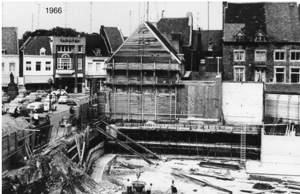
Figuur 164: Bouwput V&D op de plek van de het vroegere stadhuis
