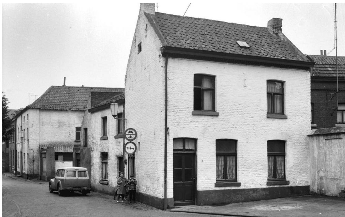
Figuur 240: Hoek Gats-Kapittelstraat nr. 2 (oude gasleiding van de straatlantaarns is nog aanwezig)
