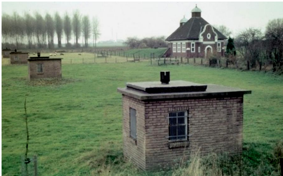
Figuur 311: Waterputten in het waterwinningsgebied Bergerweg (op de achtergrond het pompstation waarmee water naar de Kollenberg geperst wordt)
