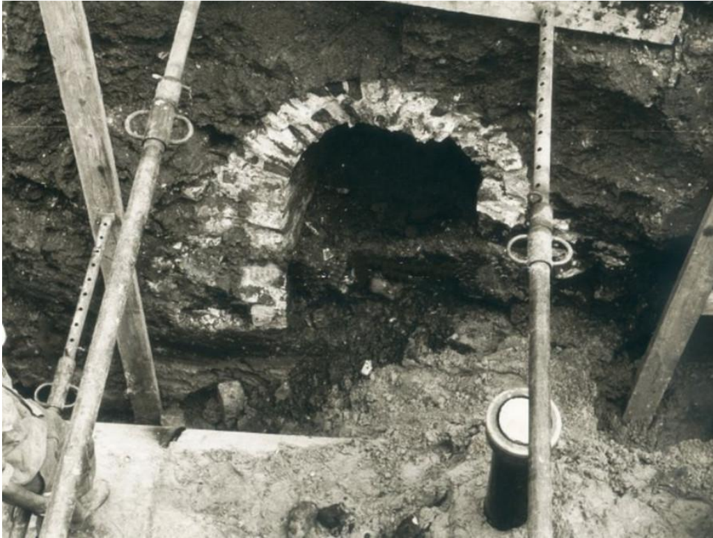
Figuur 196: Oude gemetselde overspanning van de Moelenbeek onder het Tempelplein
