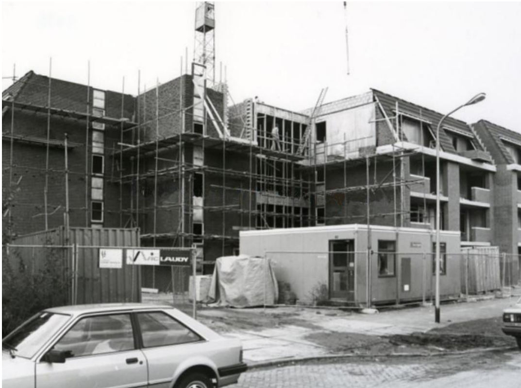
Figuur 259: Bouw bejaardencentrum 'de Baenje'
