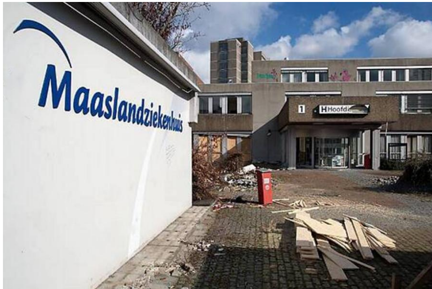
Figuur 338: Hoofdingang Maaslandziekenhuis (begin van de sloop in 2010)
