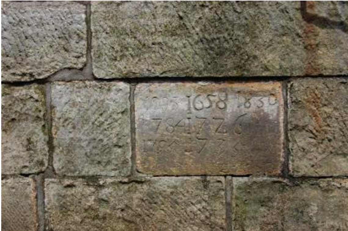
Figuur 330: Gevelsteen in de zijmuur van de Stenen Sluis met jaartallen (1658-1735-1776-..), waarin de sluis gerestaureerd werd
