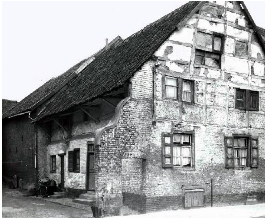
Figuur 286: Vakwerkhuis Ophoven -5 uit 1779 voor de restauratie
