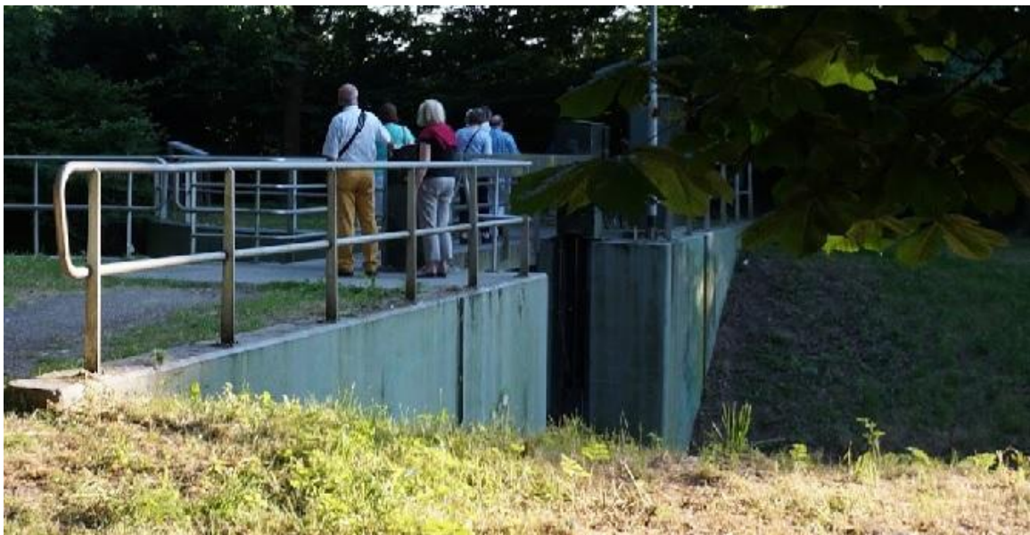
Figuur 331: Geautomatiseerde stuw naast de Stenen Sluis
