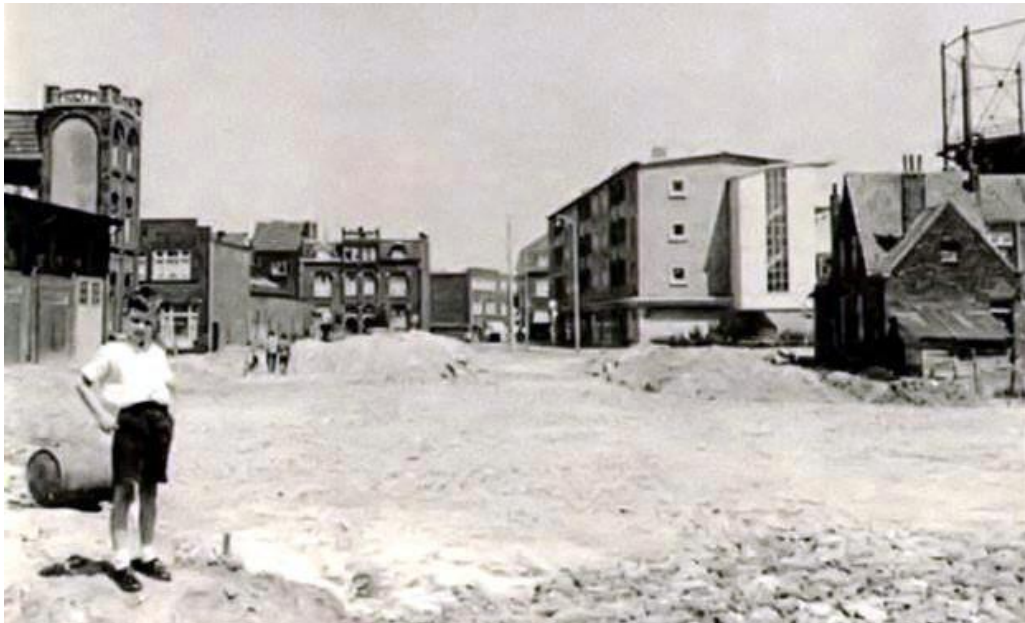
Figuur 63: Aanleg Baenjestraat op de hoek Tempelplein-Engelenkampstraat (links het oude slachthuis en rechts de gashouder)
