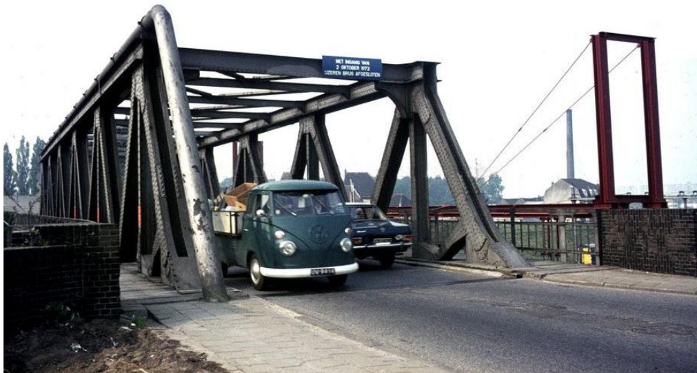
Figuur 242: IJzeren brug wordt afgesloten om gesloopt te worden (het seinhuis is al afgebroken)
