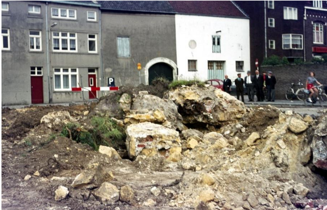
Figuur 191: Oude fundamenten van waterpoort het Steenemuurke tijdens de sloop in 1970 (Op achtergrond het woonhuis van Damoiseaux, eigenaar van de watermolen Steenen Muurke)
