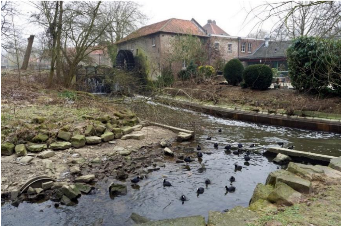
Figuur 332: Omleiding Geleenbeek bij de Ophovenermolen als vispassage
