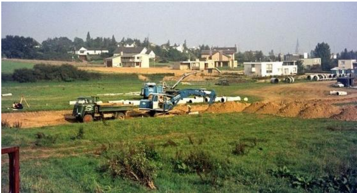
Figuur 214: Aanleg riolering en wegen in de Kollenberg
