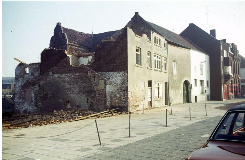
Figuur 193: De sloop van watermolen Steenen muurke is begonnen
