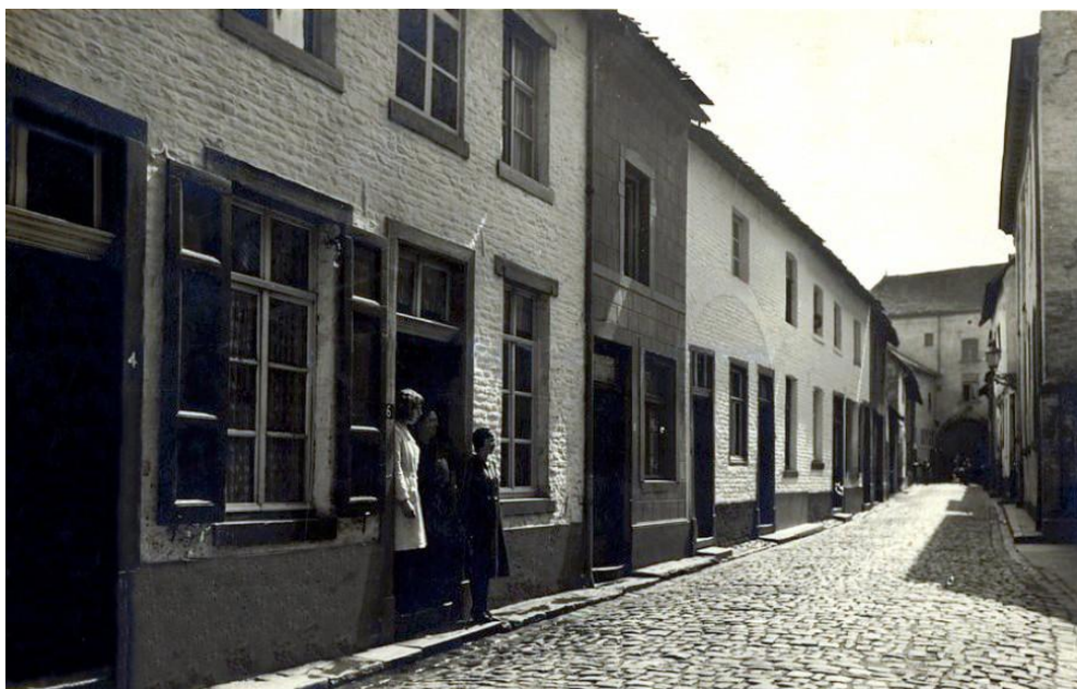
Figuur 78: Zo zag dit huis er uit voordat cement tegen de gevel gesmeerd werd: een huis in Maaslandse stijl
