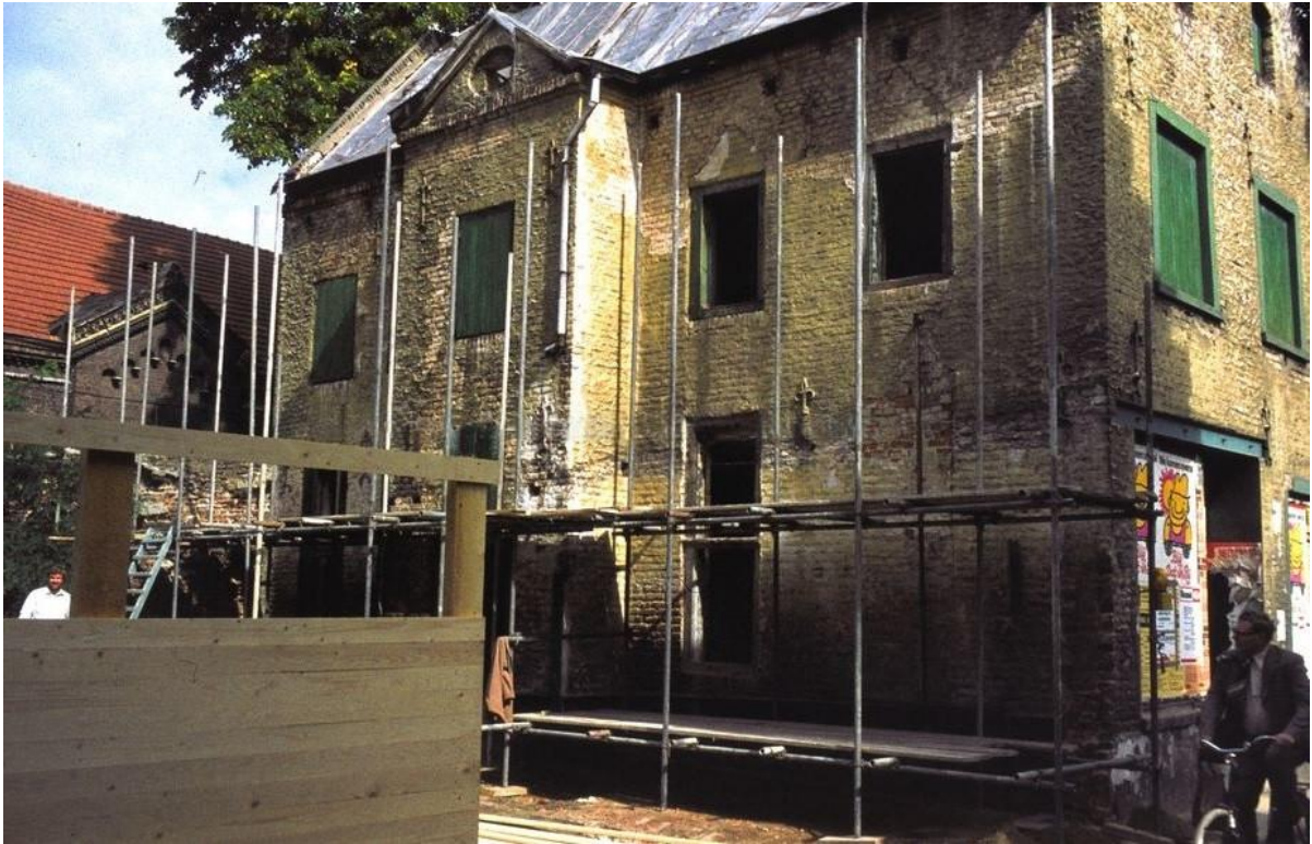
Figuur 275: Start restauratie kapittelhuis in 1976
