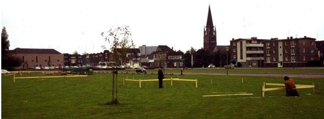
Figuur 237: Piketpaaltjes voor de bouw van het nieuwe stadhuis worden uitgezet
