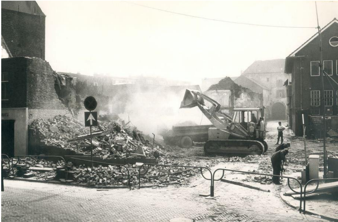
Figuur 198: Bij de banmolen is de sloop ook begonnen (hoek Molenbeekstraat – Gruizenstraat).
