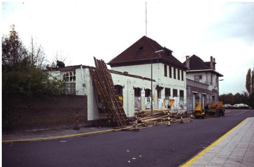
Figuur 194: Vroegere ijsfabriek aan het Tempelplein wordt ook gesloopt
