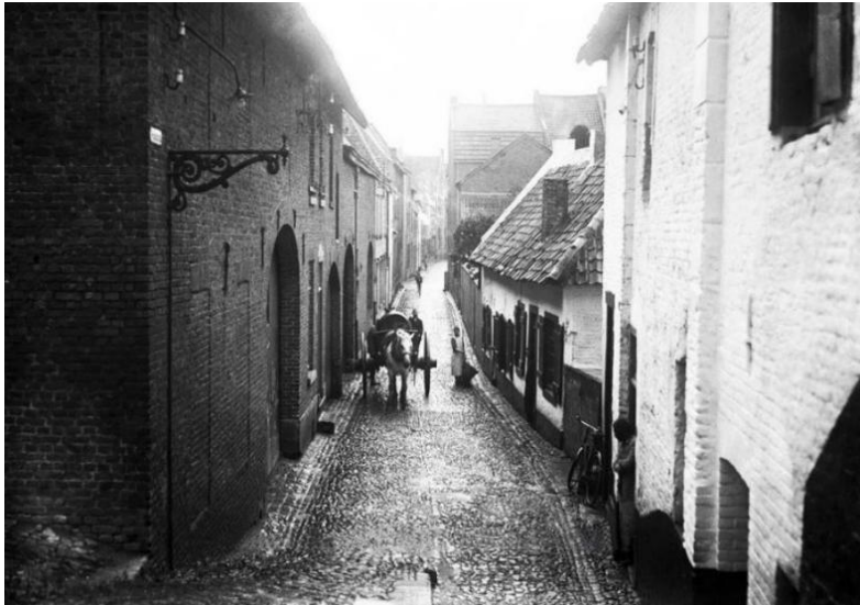
Figuur 375: Pullestraat bestraat met 'Maaskeien' rond 1930 (Links elektrische straatverlichting, de leiding van de gaslamp is nog aanwezig)
