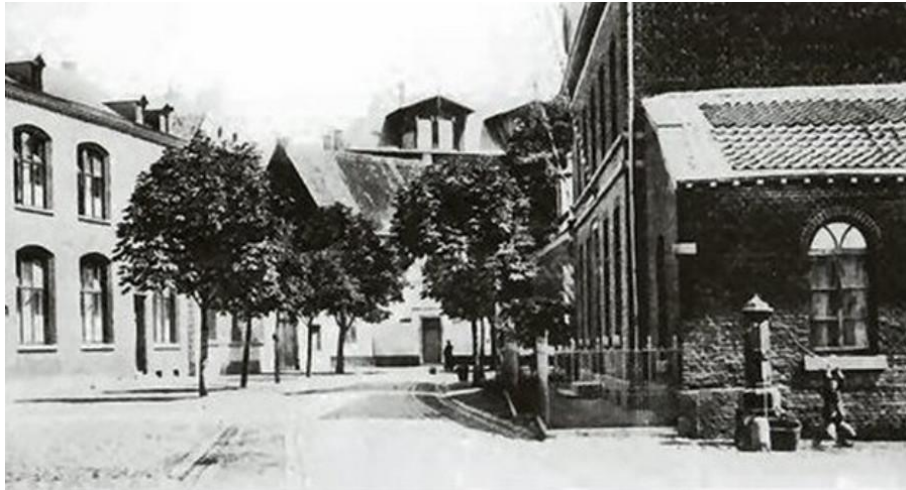
Figuur 365: Stadspomp hoek Kloosterplein – Gats in 1900, naast de pastorie
