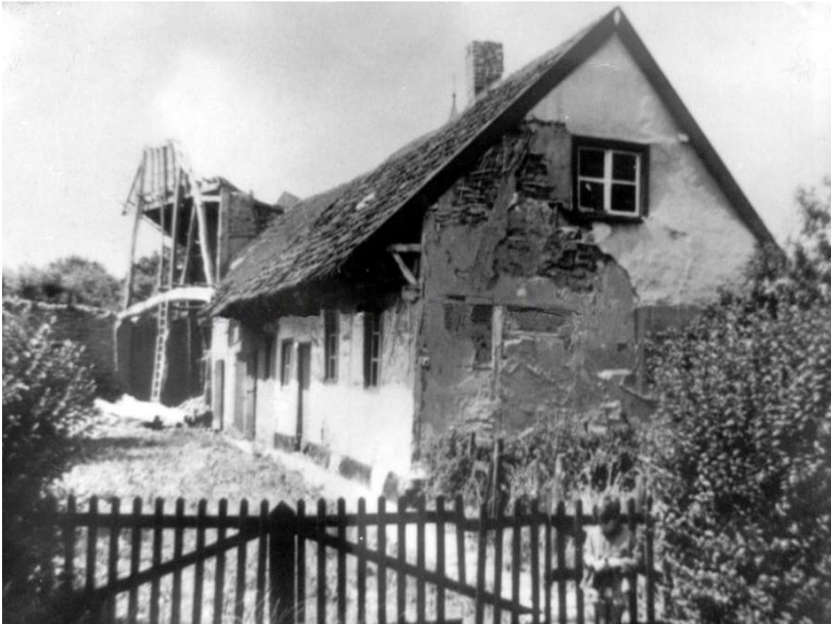
Figuur 90: Vakwerkhuis 'Bie Mooder Hacken' in Overhoven (de muren zijn van wilgentakken gemaakt, besmeerd met leem)
