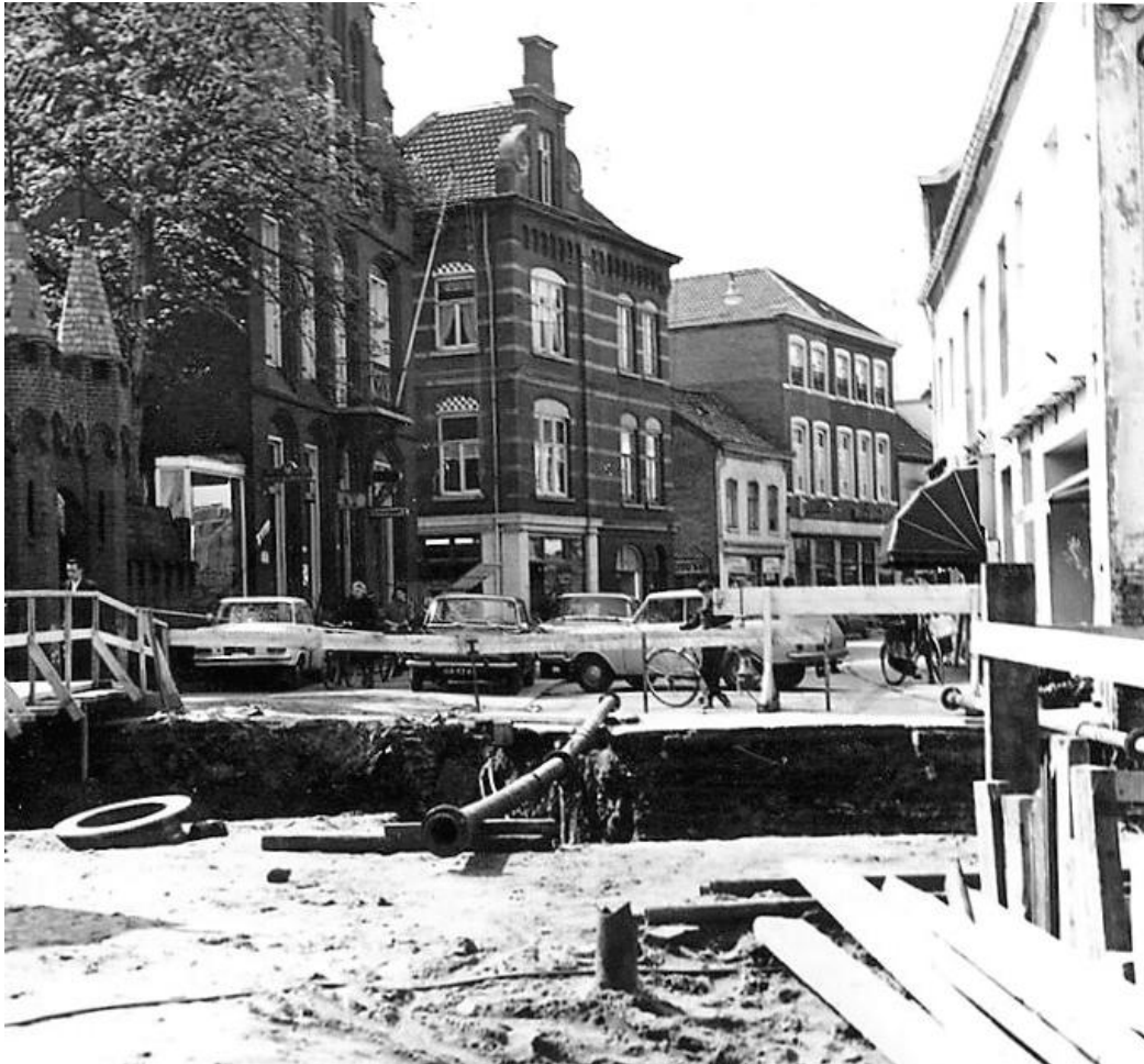
Figuur 177: In 1966 is de Boenenbrug gesloopt bij het overkluizen van de Keutelbeek
