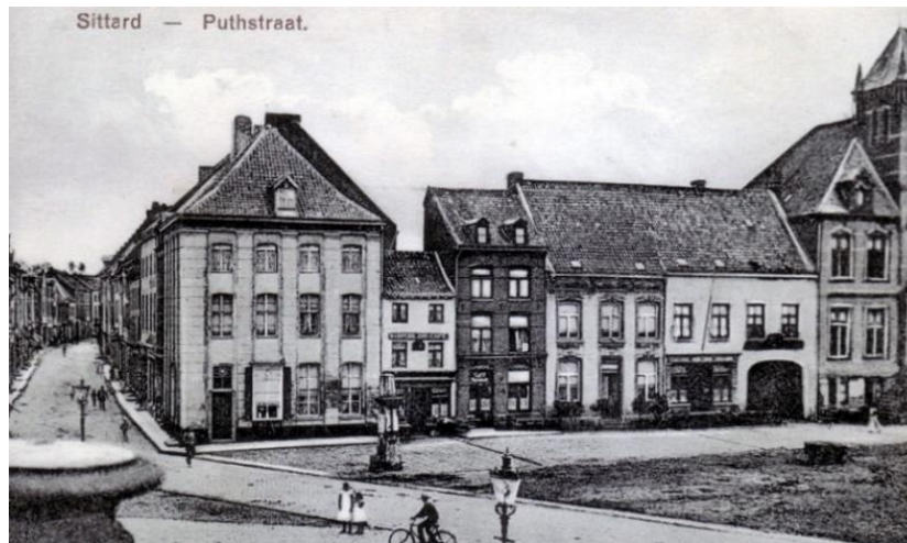
Figuur 362: Waterpomp hoek Markt-Putstraat in 1895 (vroegere waterput van de Putstraat)
