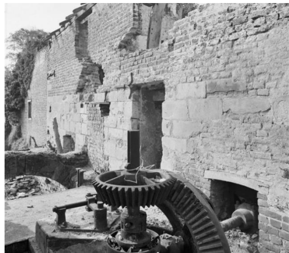
Figuur 321: Aandrijfas van de Stadbroekermolen enorm verwaarloosd in 1968
