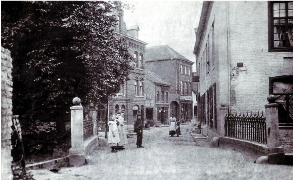
Figuur 296: De Diek begint links voor de Boenenbrug, later wordt hier de Parklaan aangelegd
