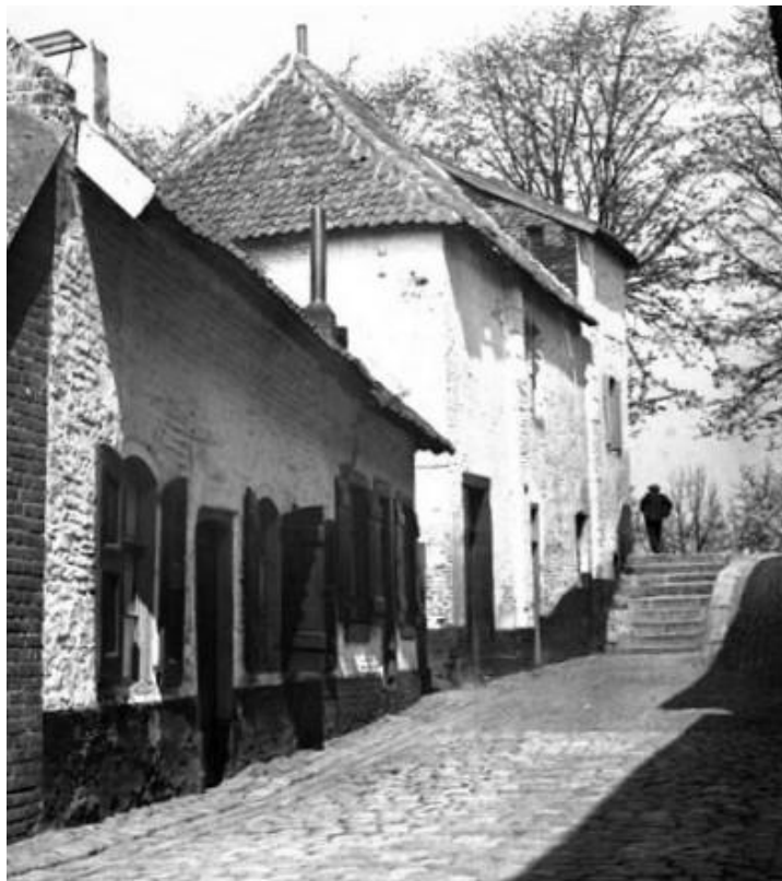
Figuur 169: Einde van de Pullestraat bij de opgang naar de wal Fort Sanderbout
