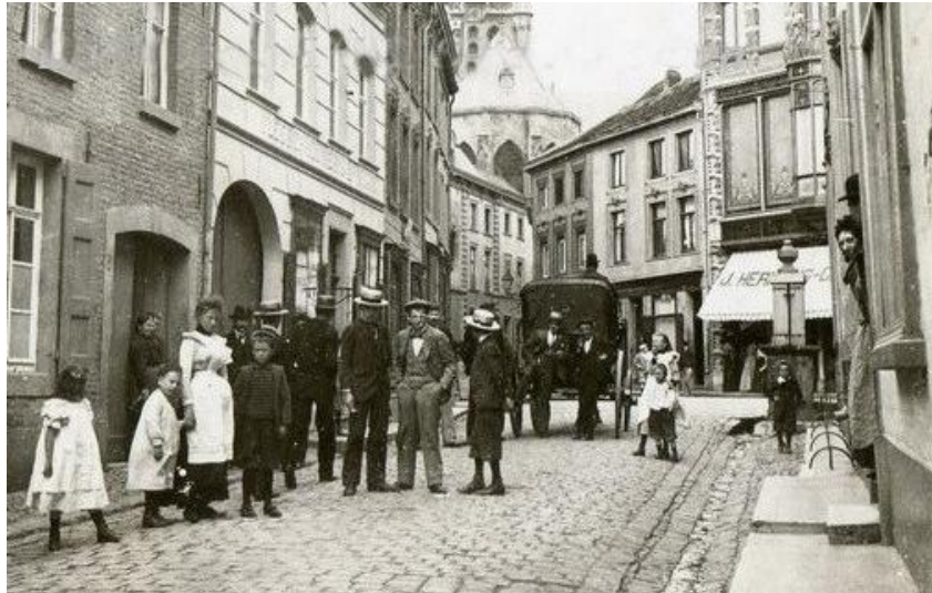
Figuur 309: Een tunnel over de stoep in de Molenstraat (elk huis had in 1905 nog zijn eigen stoep)
