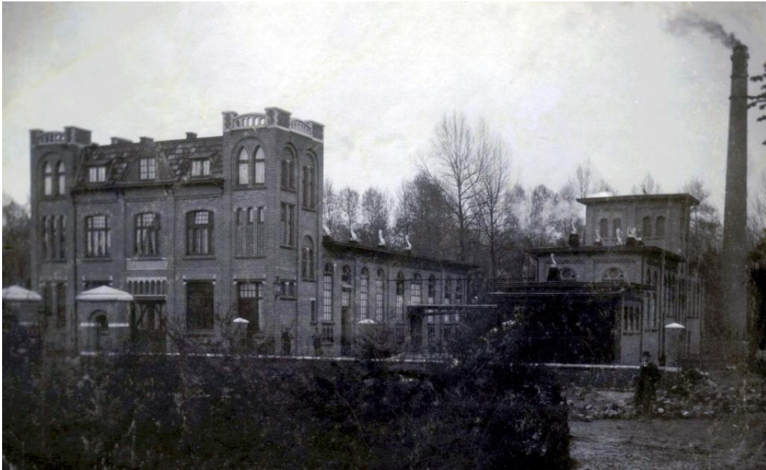
Figuur 202: Slachthuis volop in bedrijf (de windaangedreven afzuigers op de daken zijn goed te zien)
