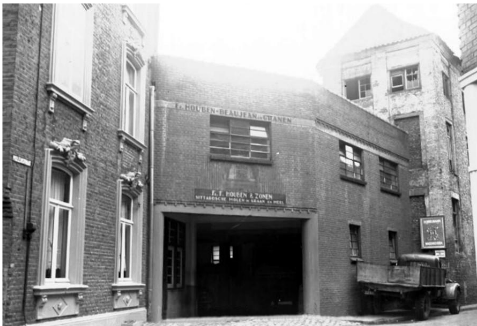
Figuur 92: Het pakhuis van de banmolen tegen de voogdij aan gebouwd in 1959
