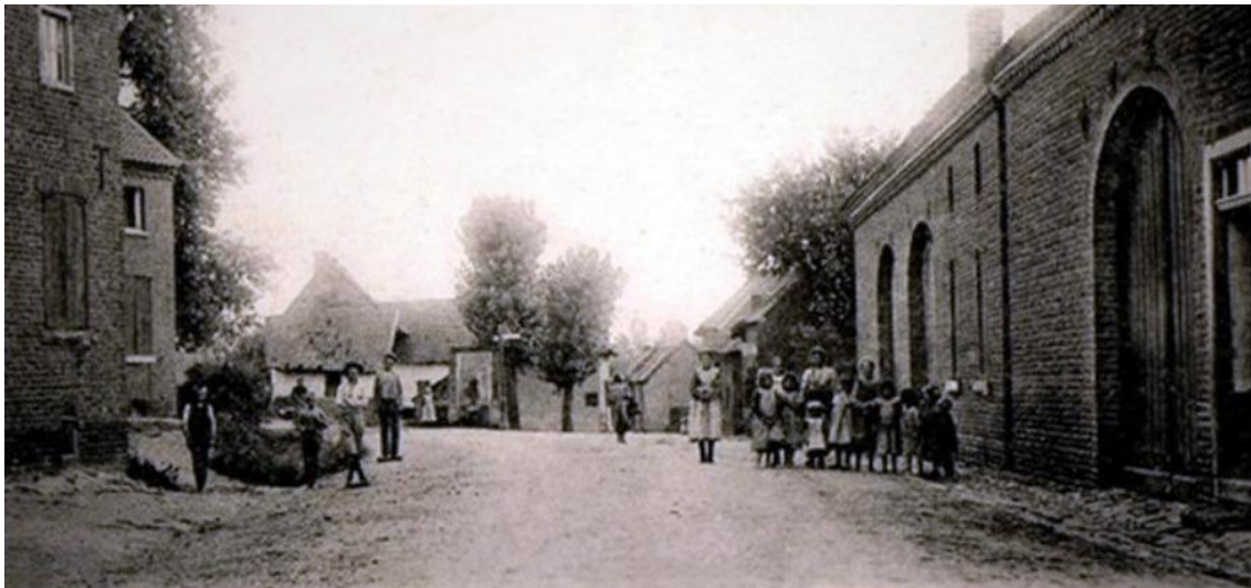
Figuur 12: Op de achtergrond de openbare waterpomp in Leijenbroek, in 1905
