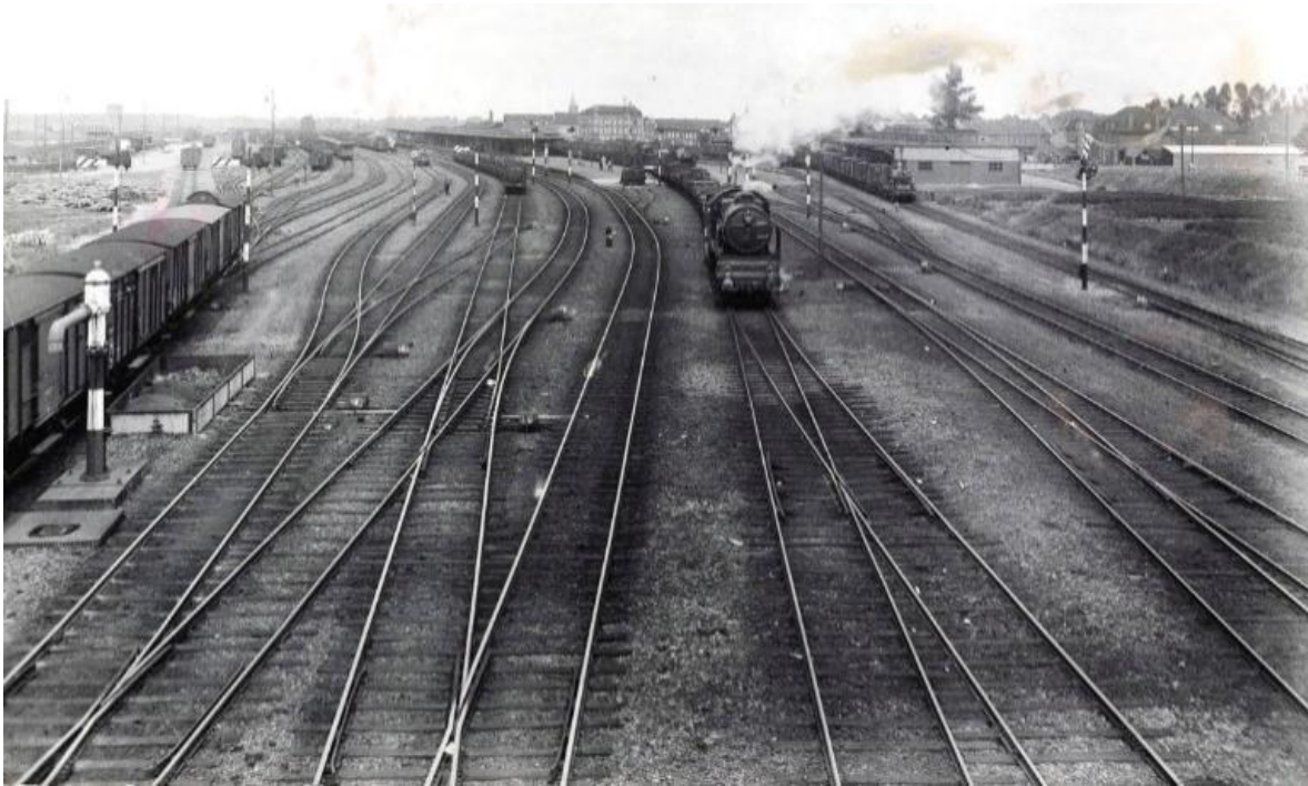
Figuur 54: Goederentrein op het uitgebreide spooremlacement in Sittard in 1925 (links een watertappunt voor de stoomlocomotieven)
