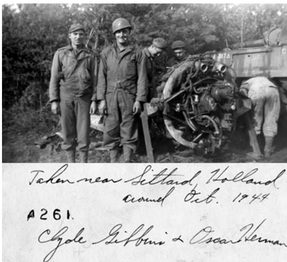
Figuur 354: Reparatie defecte tankmotor in oktober 1944
