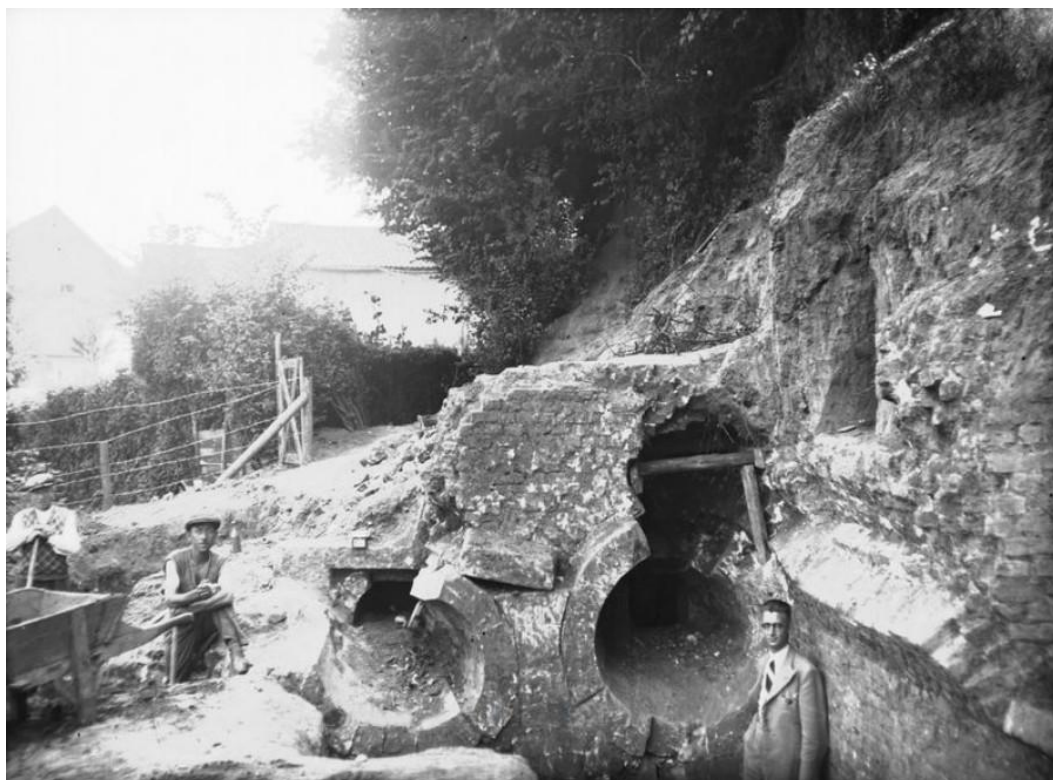
Figuur 256: Restauratiewerkzaamheden bij Fort Sanderbout
