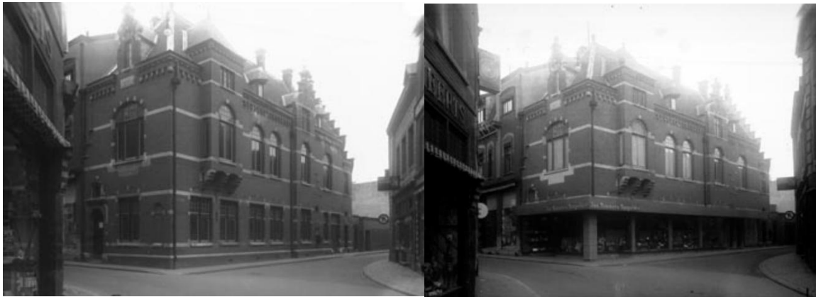
Figuur 235: Het oude postkantoor op de hoek van de Begijnenhofstraat verbouwd tot winkel
