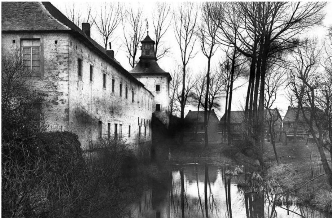
Figuur 165: Kasteelboerderij en tiendschuur in Born na de brand in 1930
