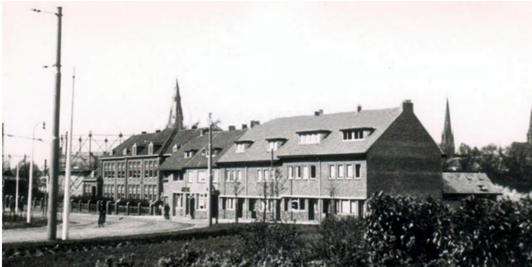
Figuur 136: Nieuwe woningen aan de Engelenkampstraat, die hier met een bocht over gaat in de Leijenbroekerweg, die nog niet verhard is
