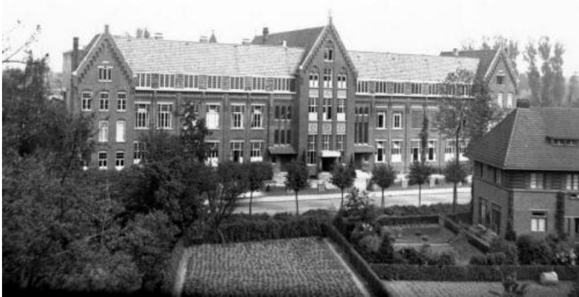
Figuur 162: Derde verdieping gebouwd op het College
