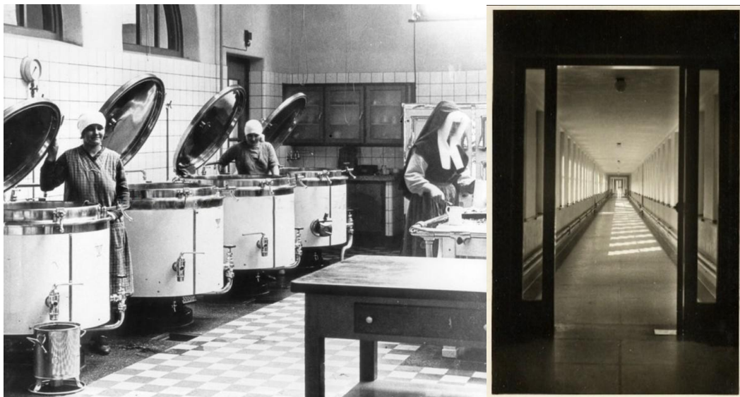
Figuur 194: Nieuwe keuken van het ziekenhuis in 1932 (rechts verbindingsgang)
