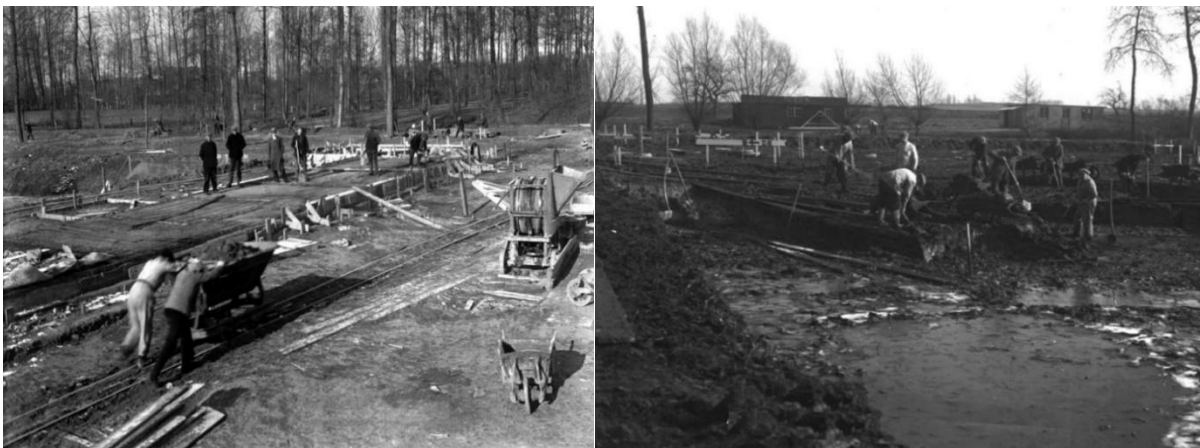
Figuur 196: Aanleg zwembad, alles wordt met de hand gedaan
