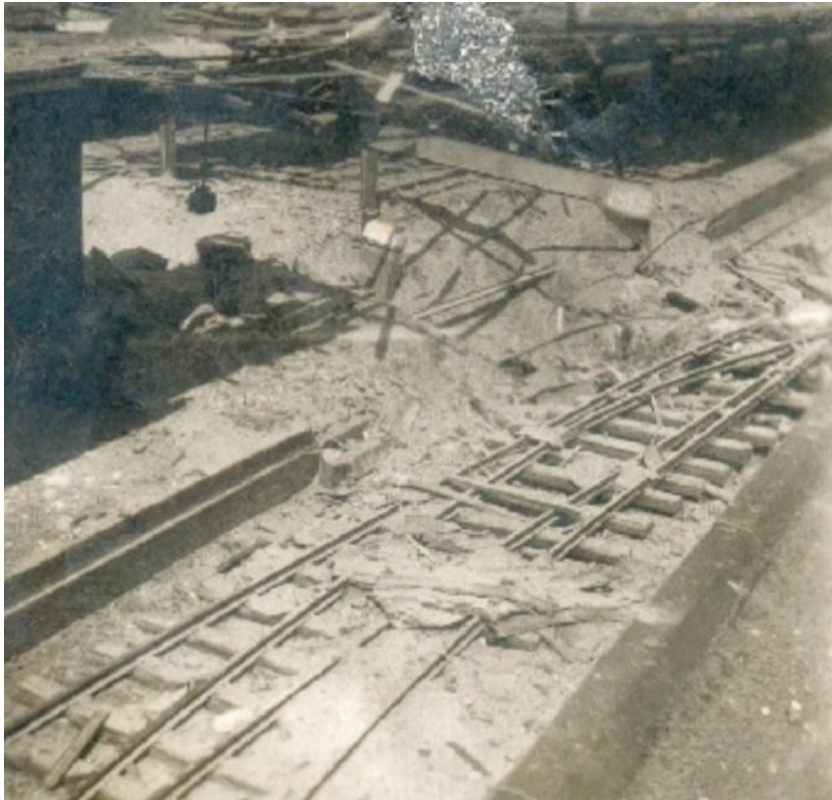
Figuur 314: Door Duitsers vernielde wissels bij het station
