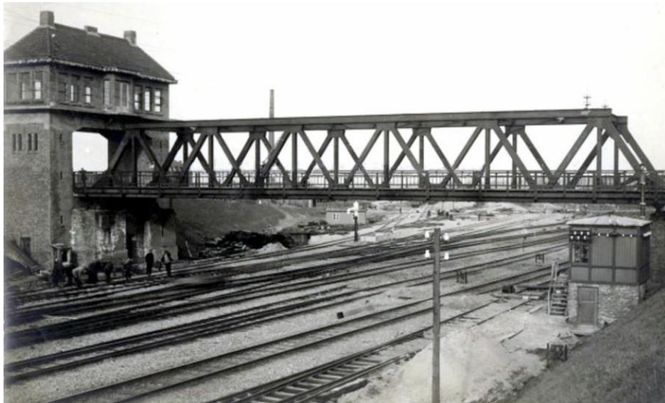
Figuur 113: De ijzeren brug ('lesere bröck') wordt in gebruik genomen
