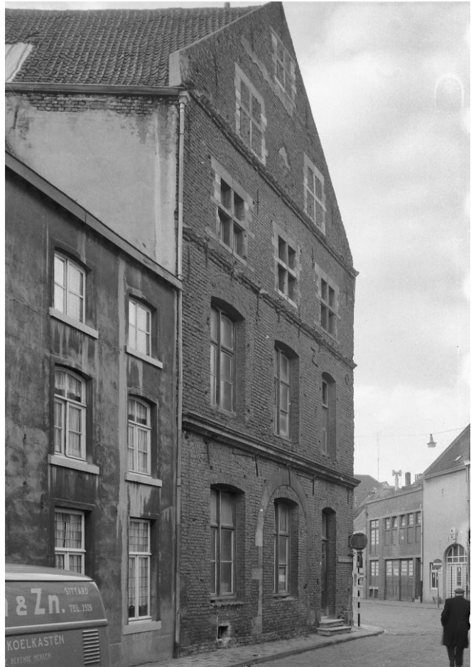
Figuur 259: Cementlaag is verwijderd van het Kritzraedthuis
