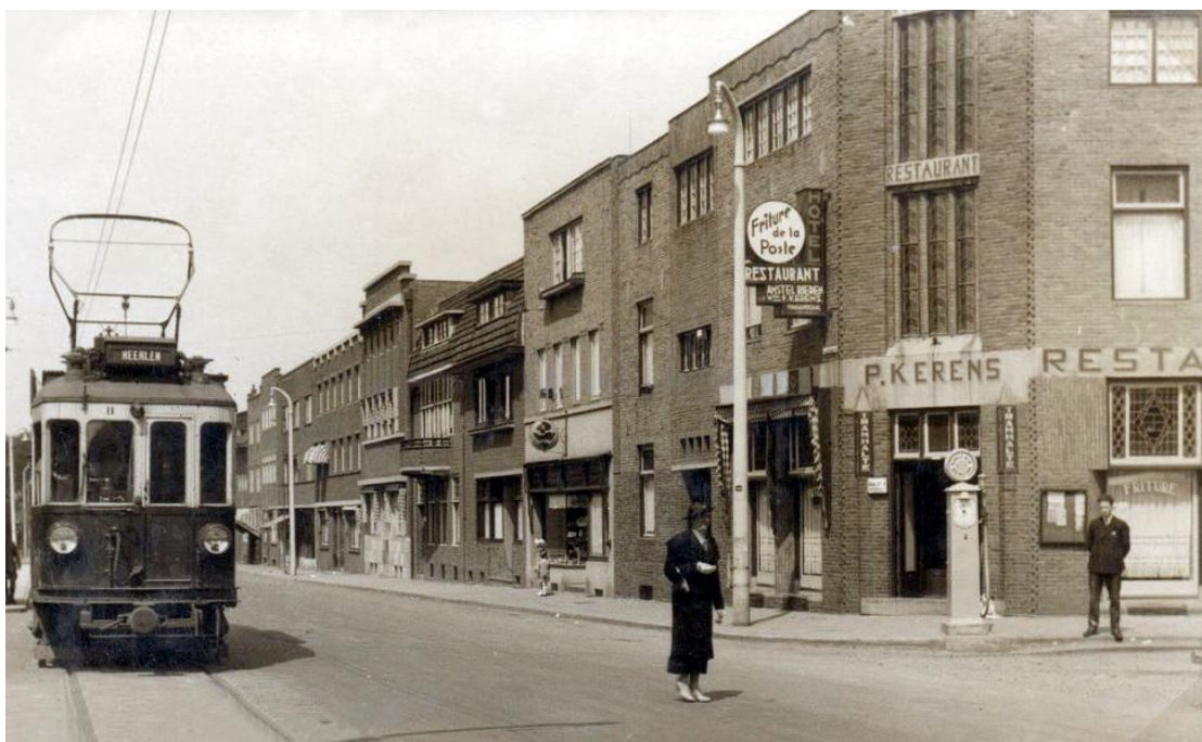
Figuur 8: Tram Sittard – Heerlen op de Engelenkampstraat bij het Tempelplein
