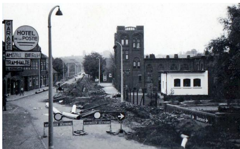
Figuur 418: Tramrails worden weggehaald bij het vroegere slachthuis en nieuwe riolering aangelegd
