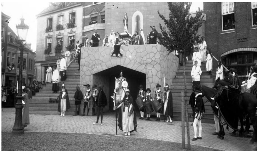
Figuur 60: Nagebouwde Putpoort op de hoek Markt-Putstraat
