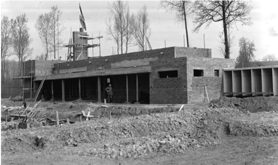
Figuur 198: Ingangsgebouw van het zwembad, links de kleedkamers van de meisjes en rechts de jongens
