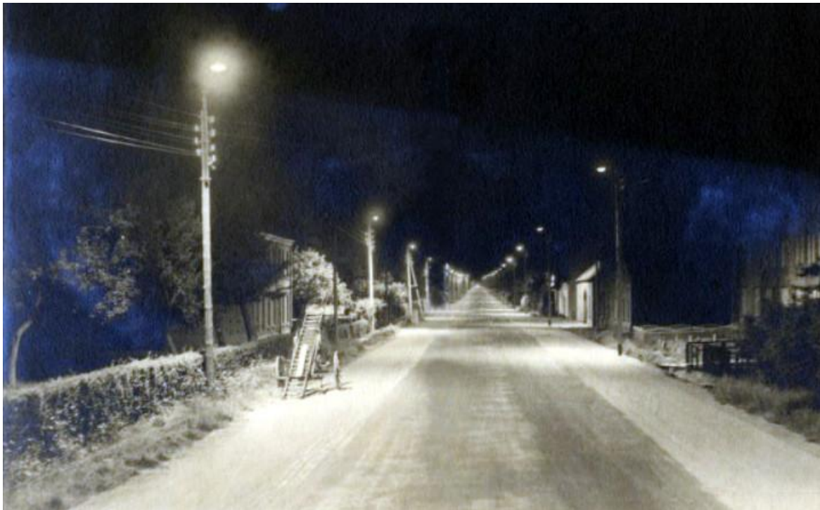
Figuur 199: Wegverlichting met natriumlampen op de Rijksweg
