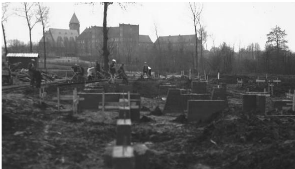
Figuur 197: Fundering van het ingangsgebouw, op de achtergrond het klooster van Leijenbroek
