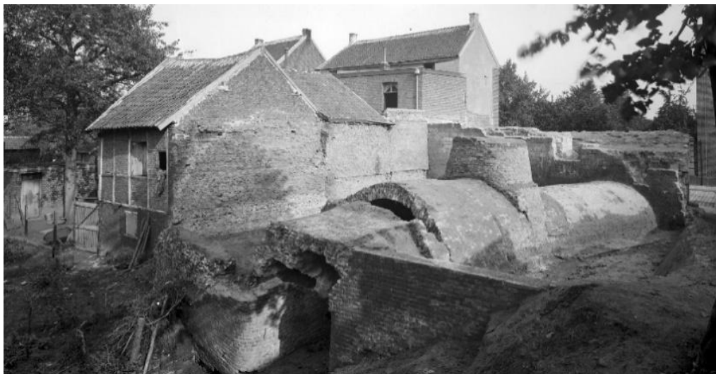
Figuur 18: Uitgegraven Fort Picard in 1923, resten bevinden zich nog onder 'Huis op 't fort'
