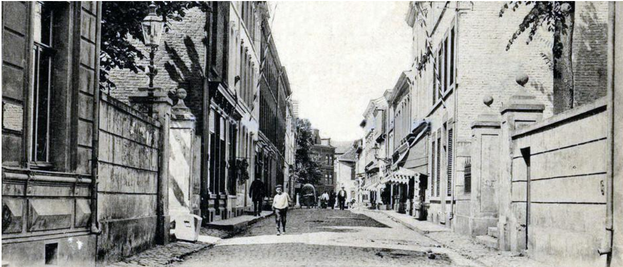
Figuur 74: Links de vroegere opgang naar de wal in de Brandstraat die afgebroken wordt voor de aanleg van de Walstraat; rechts de opgang naar de Begijnenhofwal, die met een hek konden worden afgesloten
