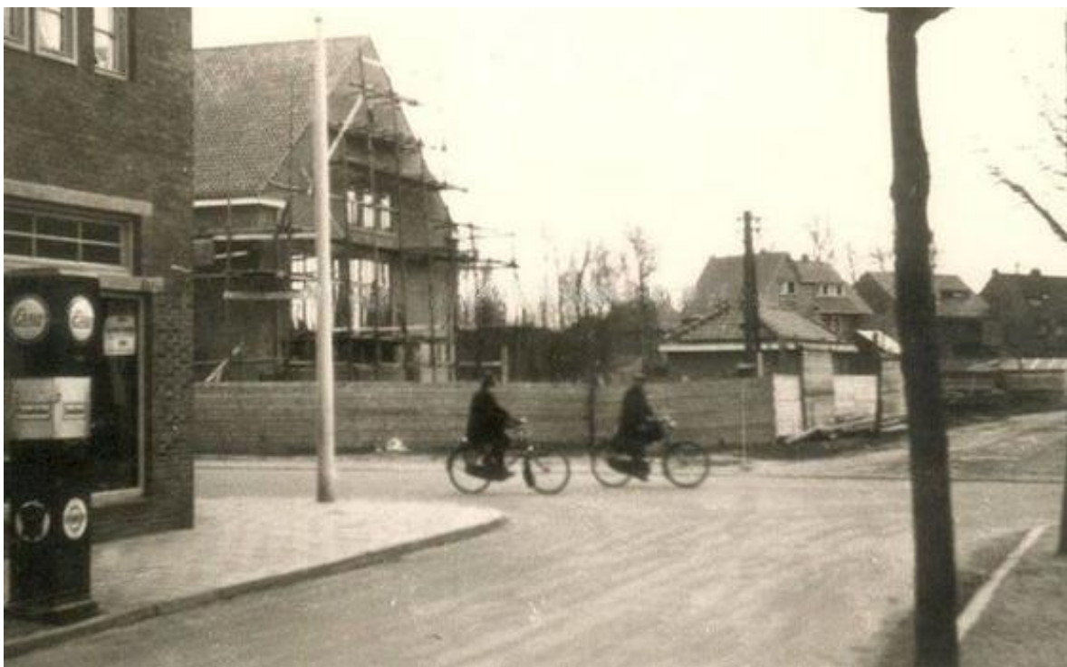
Figuur 230: Bouw van het postkantoor, de Gouverneur van Hövellstraat moet nog aangelegd worden
