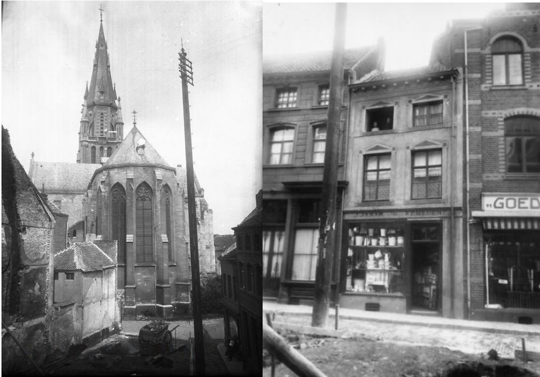
Figuur 28: Telegraafpaal bij de St. Petruskerk in het Kerkstraatje 1924 (bovenop de paal is een bliksemafleider zichtbaar)
